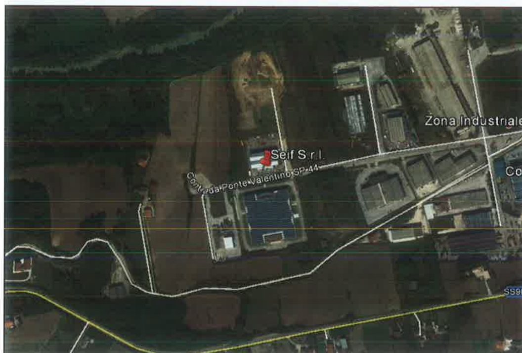
Figura 5-7: Impianto Seif S.r.l., foto aerea
