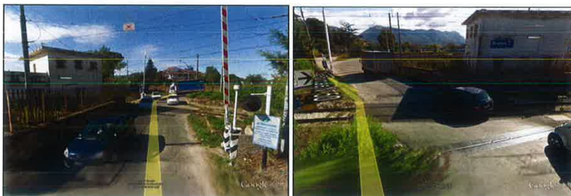
Figura 2-4: Passaggio a livello attuale
