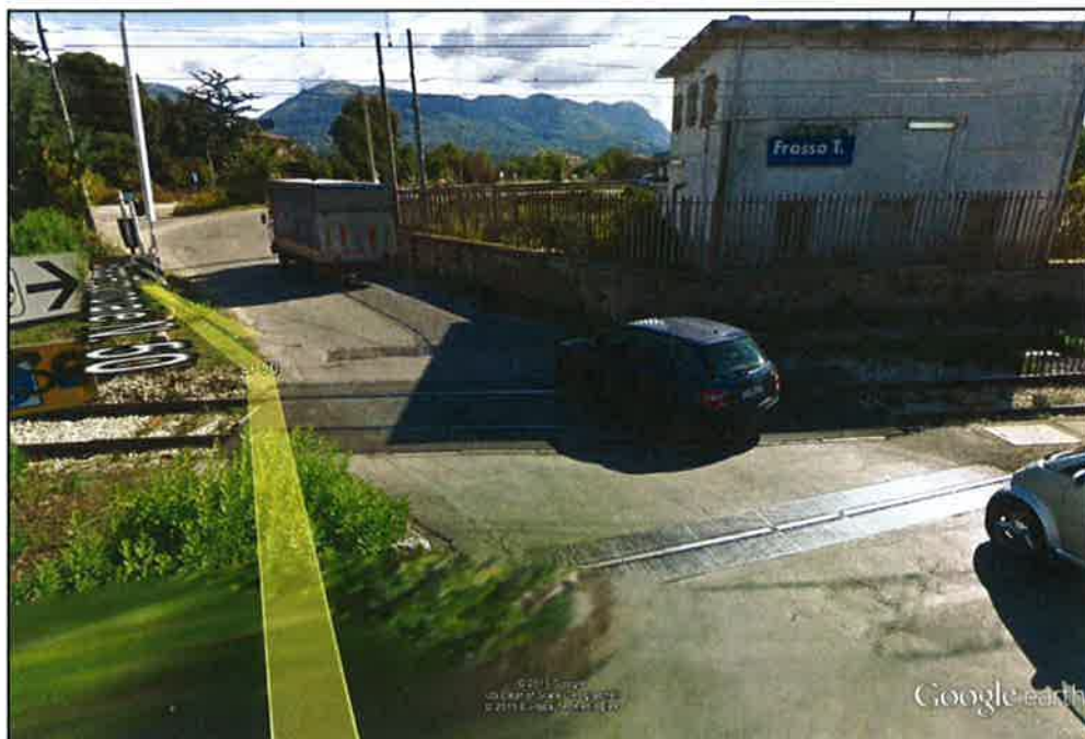
Figura 4-5 -Passaggio a livello attuale
