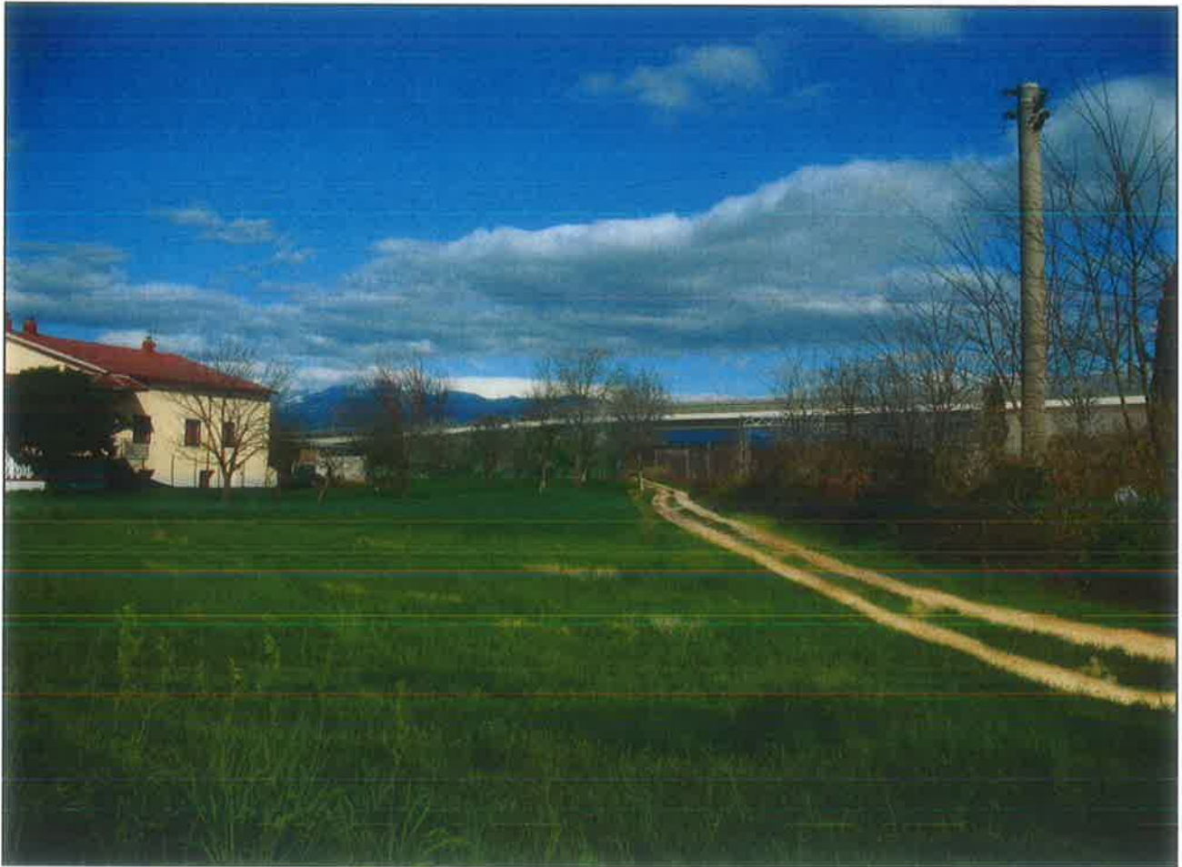
Figura 6-6 - Foto dal punto di vista individuato per il fotoinserimento "A": situazione post-operam
