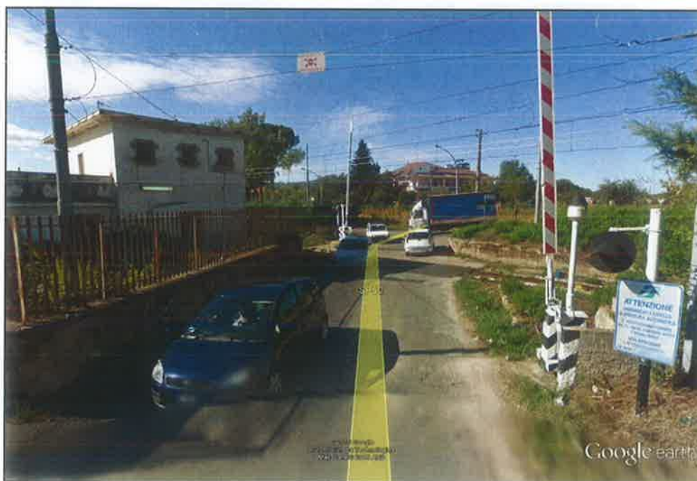
Figura 4-4 -Passaggio a livello attuale
