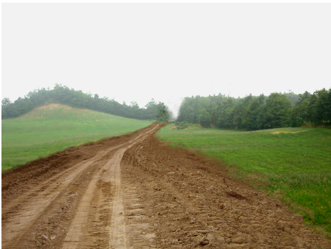
Fig. 4.1/l: Ripristino di linea
