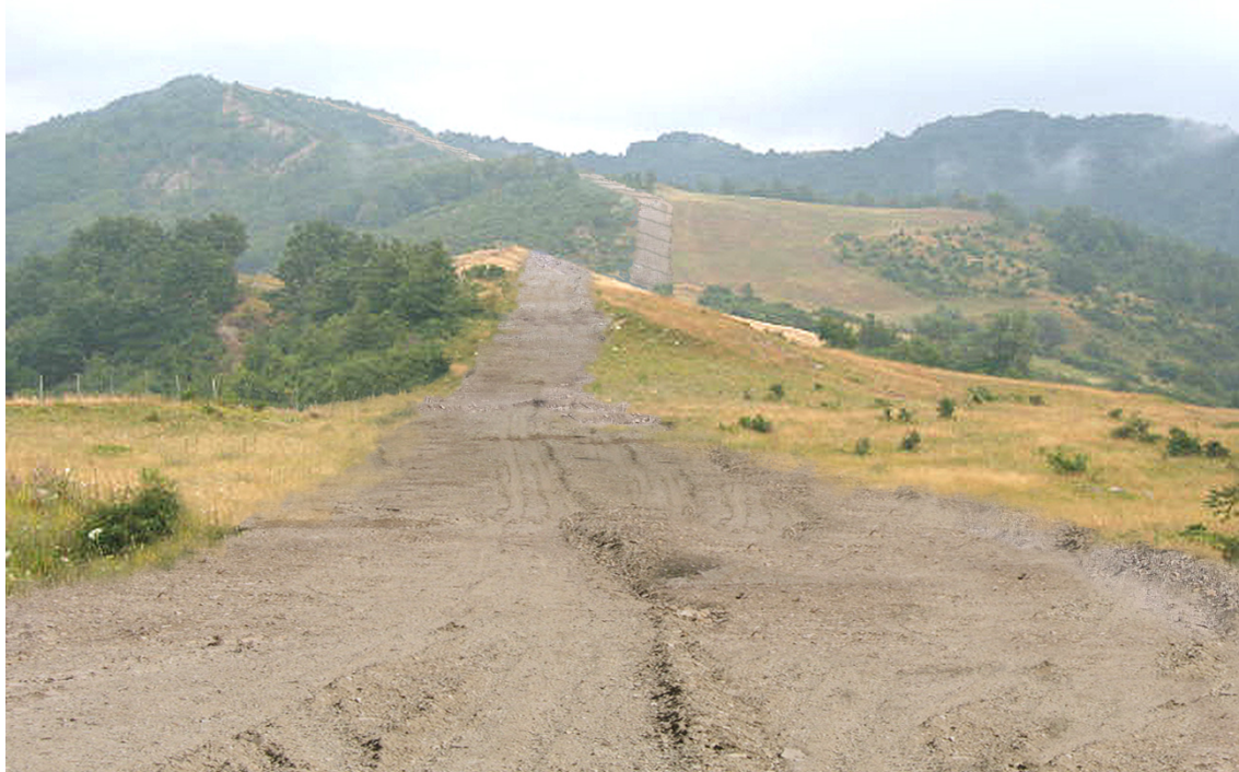
Fig. 4.1/P: Ripristino di linea
