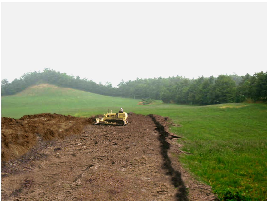
Fig. 4.1/G: Apertura della pista, accantonamento dello strato humico
