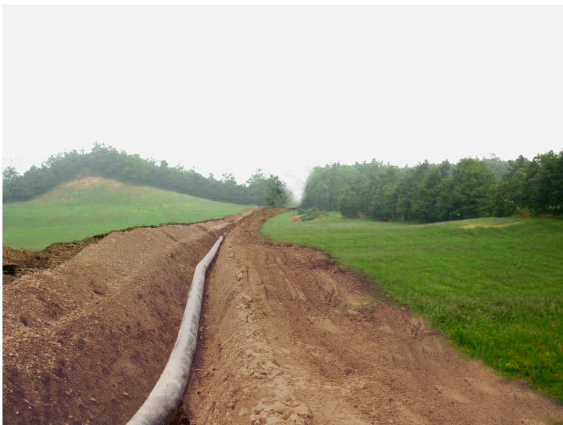
Fig. 4.1/H: Ritombamento della trincea
