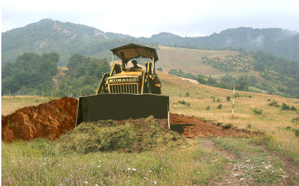
Fig. 4.1/N: Scotico dello strato umico superficiale
