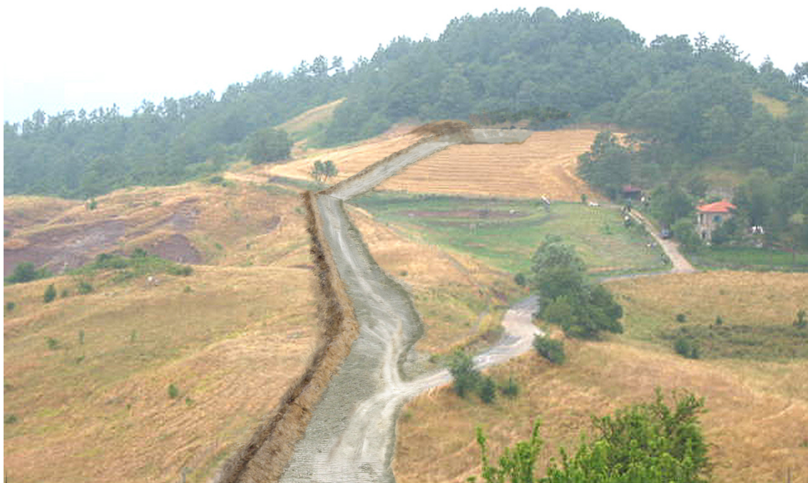
Fig. 4.1/S: Apertura della pista
