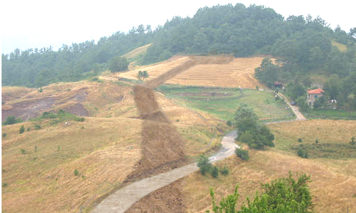
Fig. 4.1/U: Ripristino di linea
