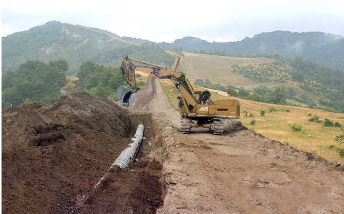
Fig. 4.1/O: Ritombamento della trincea
