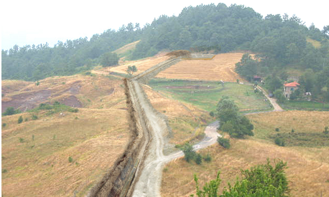
Fig. 4.1/T: Ritombamento della trincea
