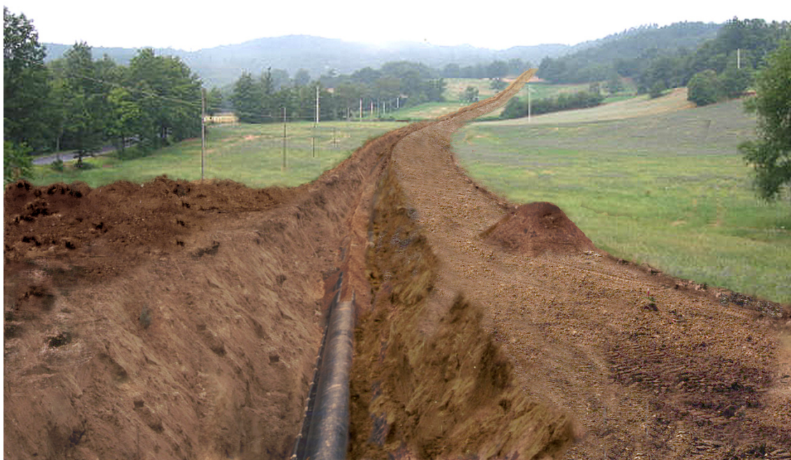
Fig. 4.1/C: Ritombamento della trincea
