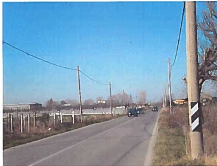
SP 74 "Ponte dei Cani" in corrispondenza della nuova intersezione a rotatoria
