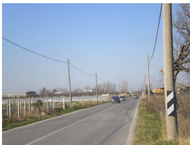
Fig. 4. SP 74 "Ponte dei Cani" in corrispondenza della nuova intersezione a rotatoria
