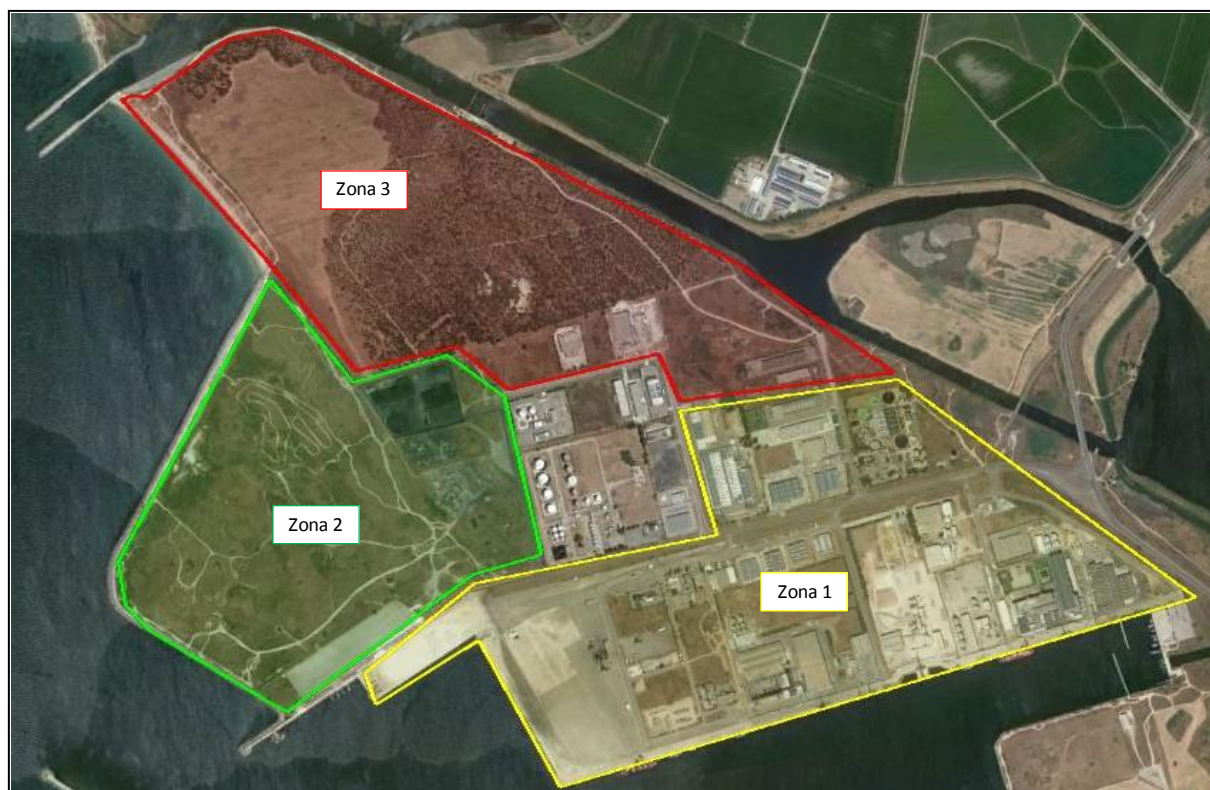
Figura 10 – Aree di indagine all'interno del porto industriale
