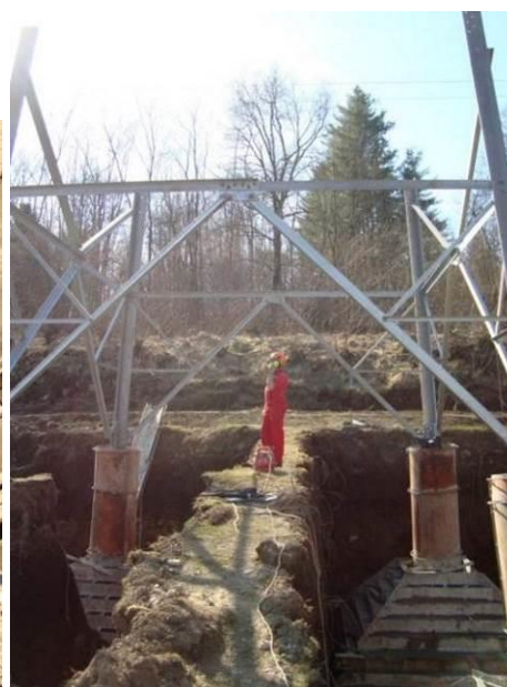
Figura 10.2 - Esempio di realizzazione del piede di fondazione
