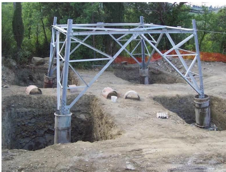
Figura 10.1 - Esempio di fondazione di un sostegno
