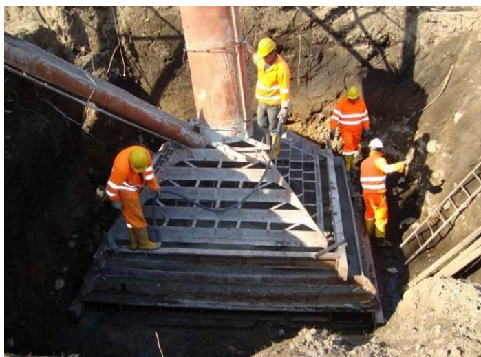
Figura 10.2 - Esempio di realizzazione del piede di fondazione
