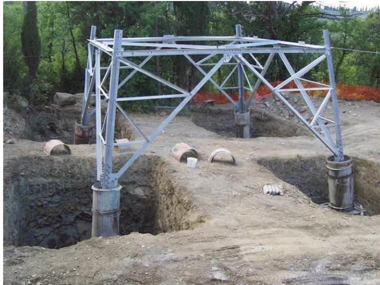
**Figura 3.4 - Esempio di fondazione di un sostegno**
