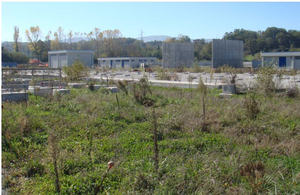
Fig.1 – Area di ubicazione della stazione elettrica 220/150 kV di Montesano
