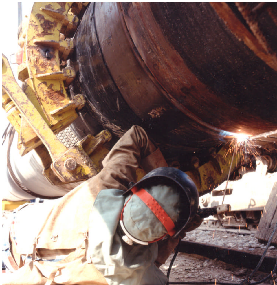
Fig. 5.1/D Saldatura di linea
