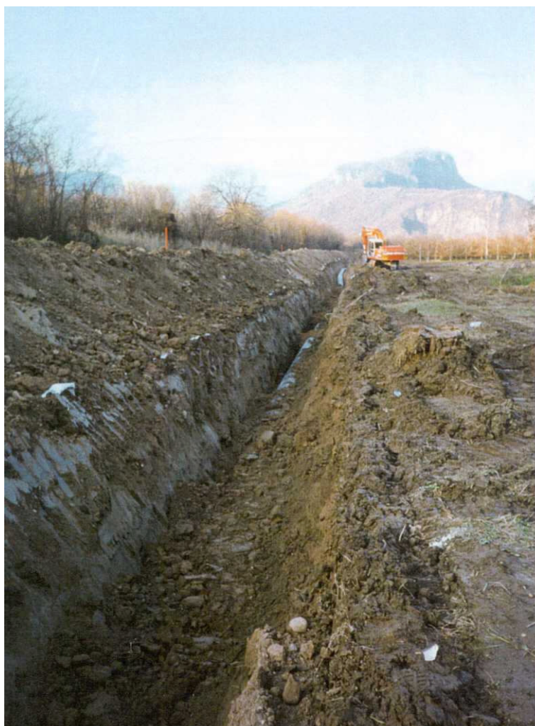
Fig. 5.1/H Rinterro della condotta
