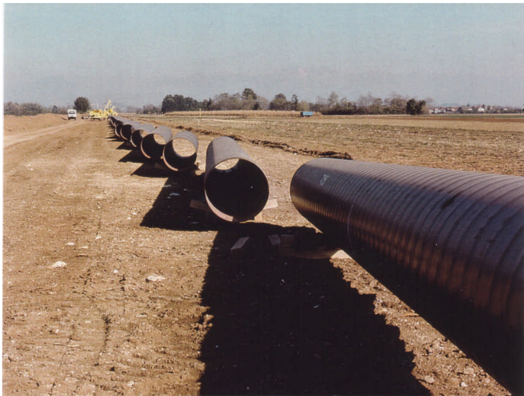
Fig. 5.1/C Sfilamento tubazioni
