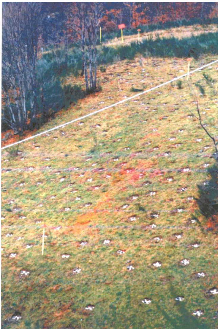
Foto 9/A Ripristino vegetazionale eseguito nel 1997: la messa a dimora delle piante viene fatta su tutta la pista del metanodotto. Al termine del lavoro di messa a dimora vengono eseguite le cure colturali alle piantine ed il risarcimento delle fallanze.
