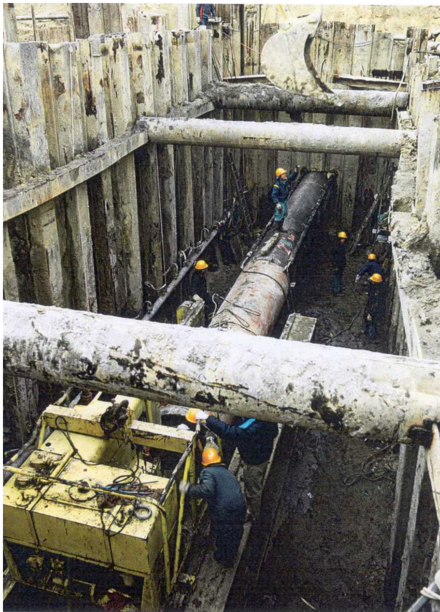
Foto 5.1/L: Trivellazione con spingitubo
