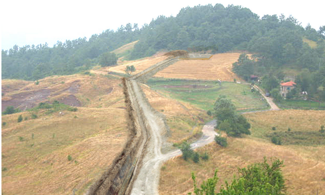
Fig. 4.1/T: Ritombamento della trincea
