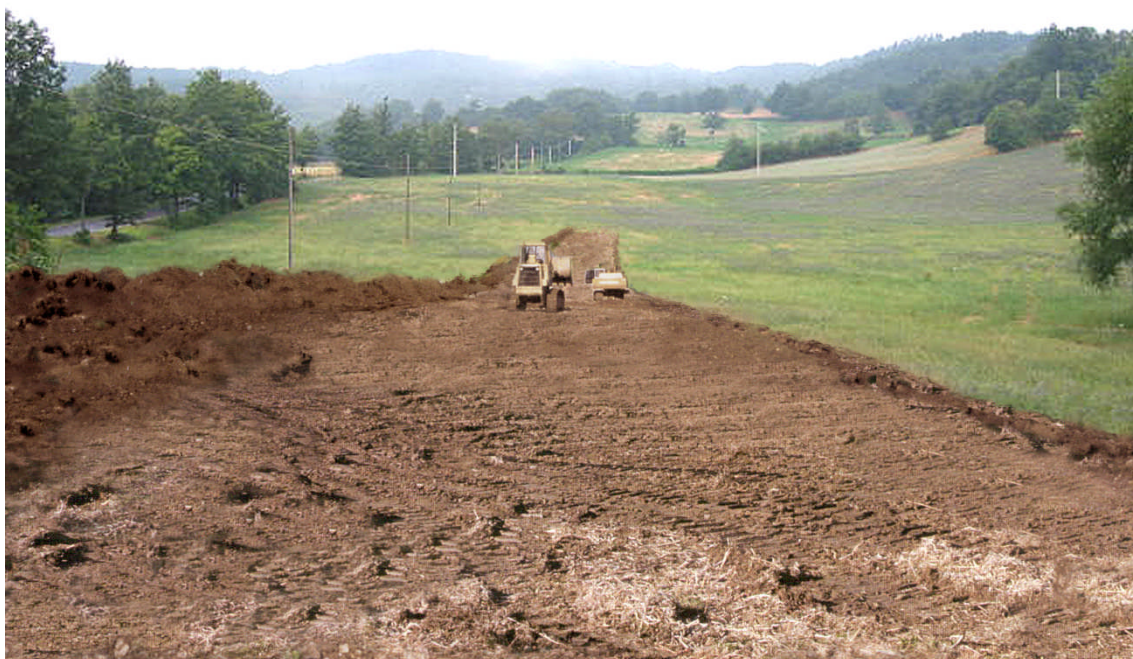
Fig. 4.1/B: Apertura della pista
