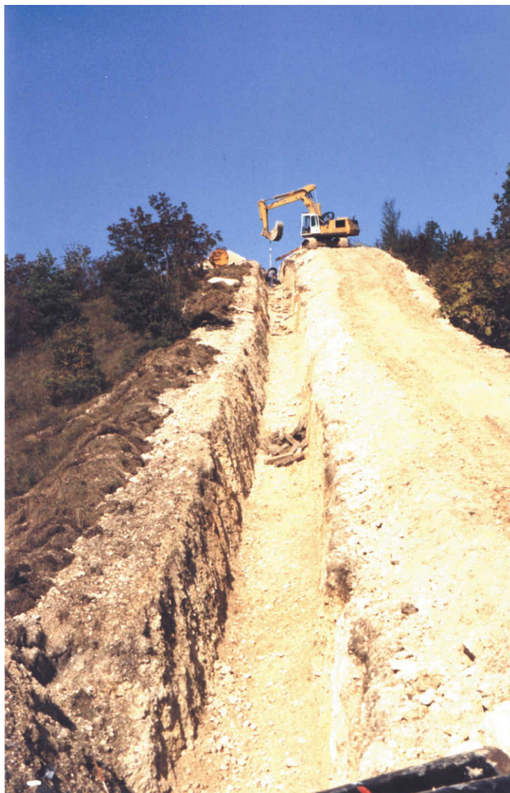
Fig. 5.1/E Scavo della trincea
