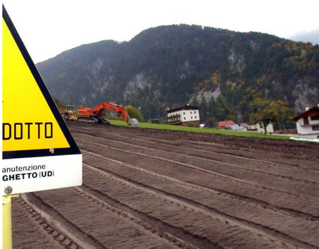
Fig. 5.1/l: Ridistribuzione dello strato humico superficiale
