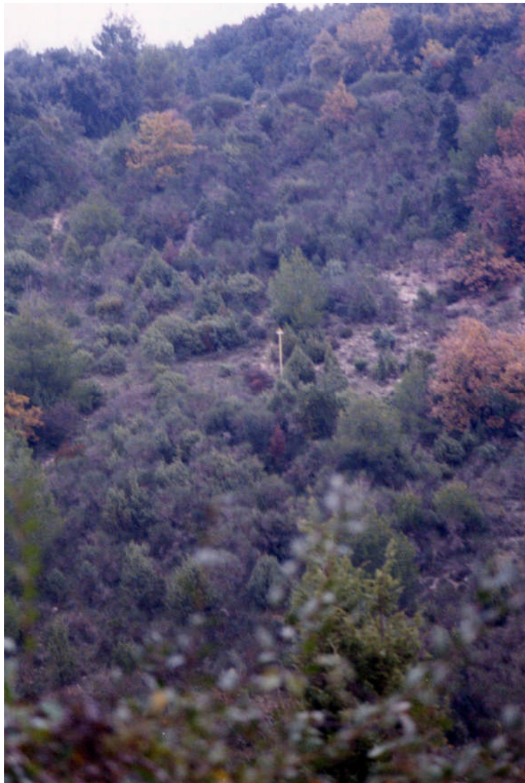
Foto 9/E Lavori di costruzione terminati 30 anni fa: il tracciato del metanodotto è difficilmente individuabile, la vegetazione ha ormai ricoperto tutto il versante.
