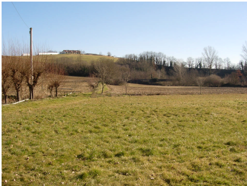
Foto 3.3/A: Particolare della scarpata al piede del versante sinistro generata dell'erosione del corso d'acqua (sponda in battuta dell'ansa fluviale).
