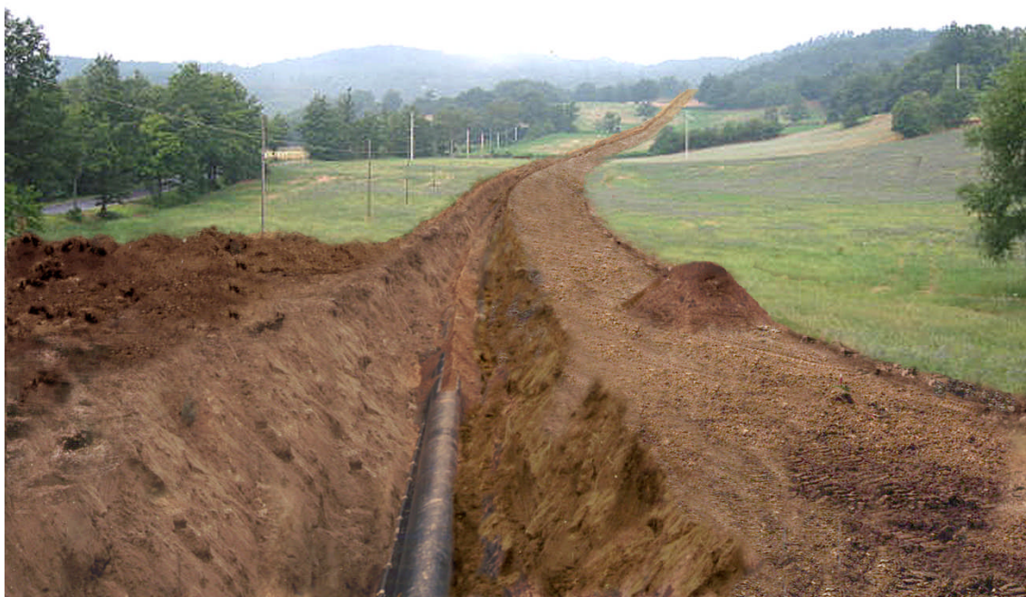
Fig. 4.1/C: Ritombamento della trincea
