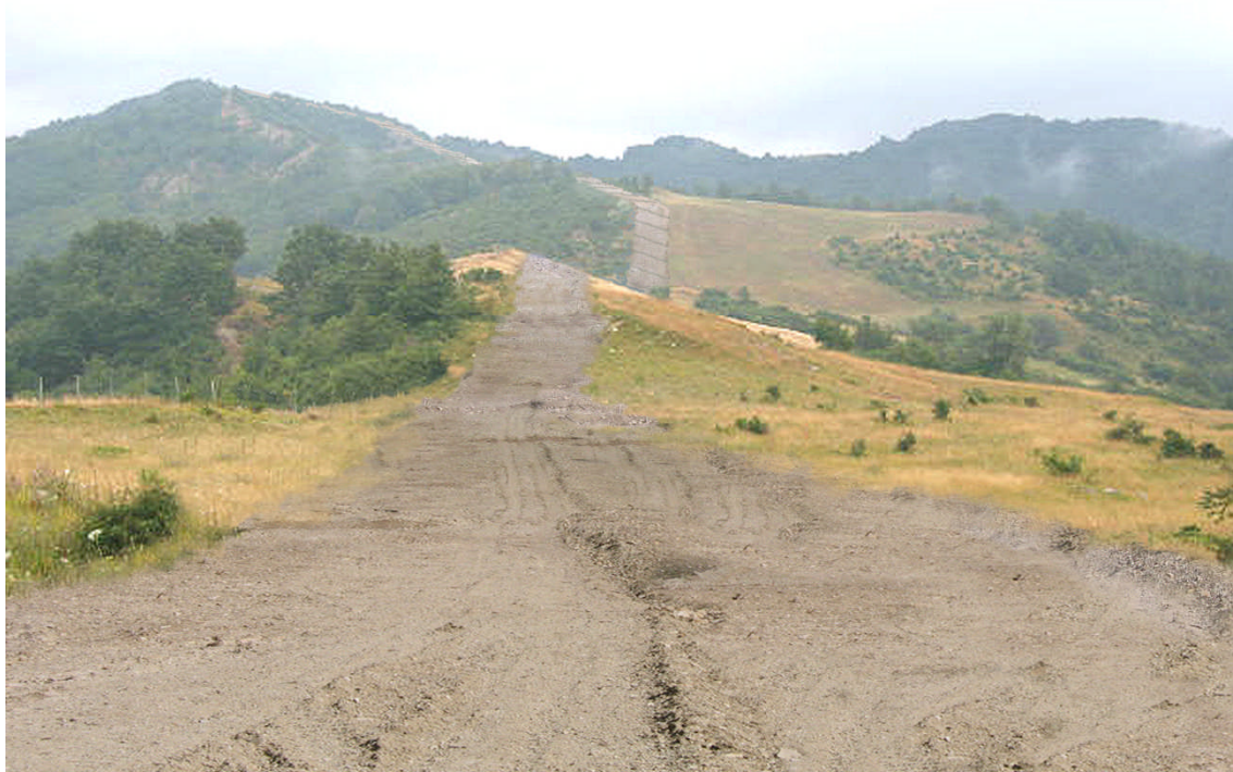
Fig. 4.1/P: Ripristino di linea
