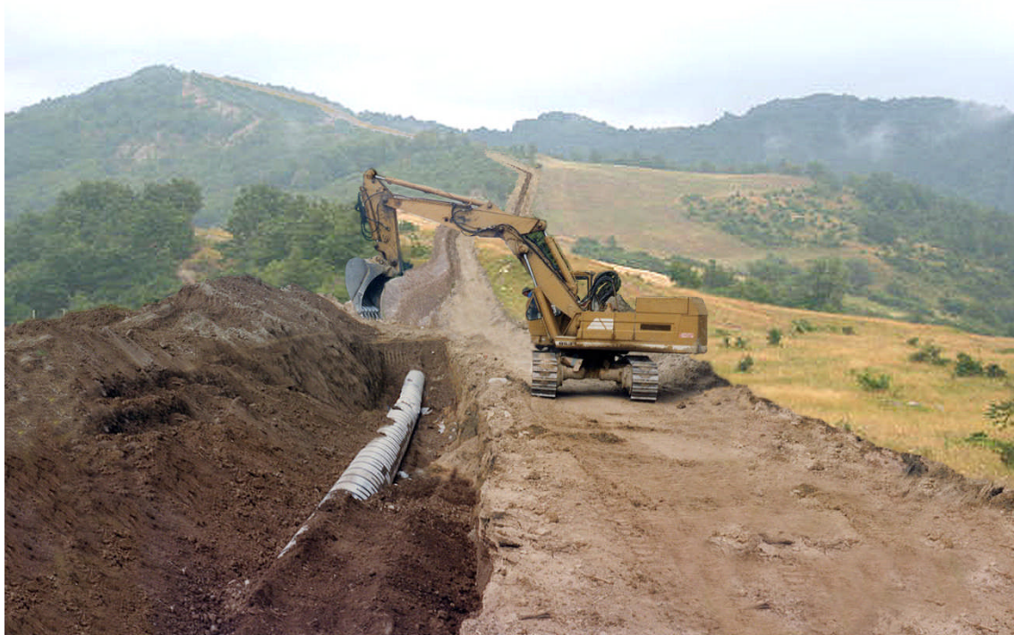
Fig. 4.1/O: Ritombamento della trincea
