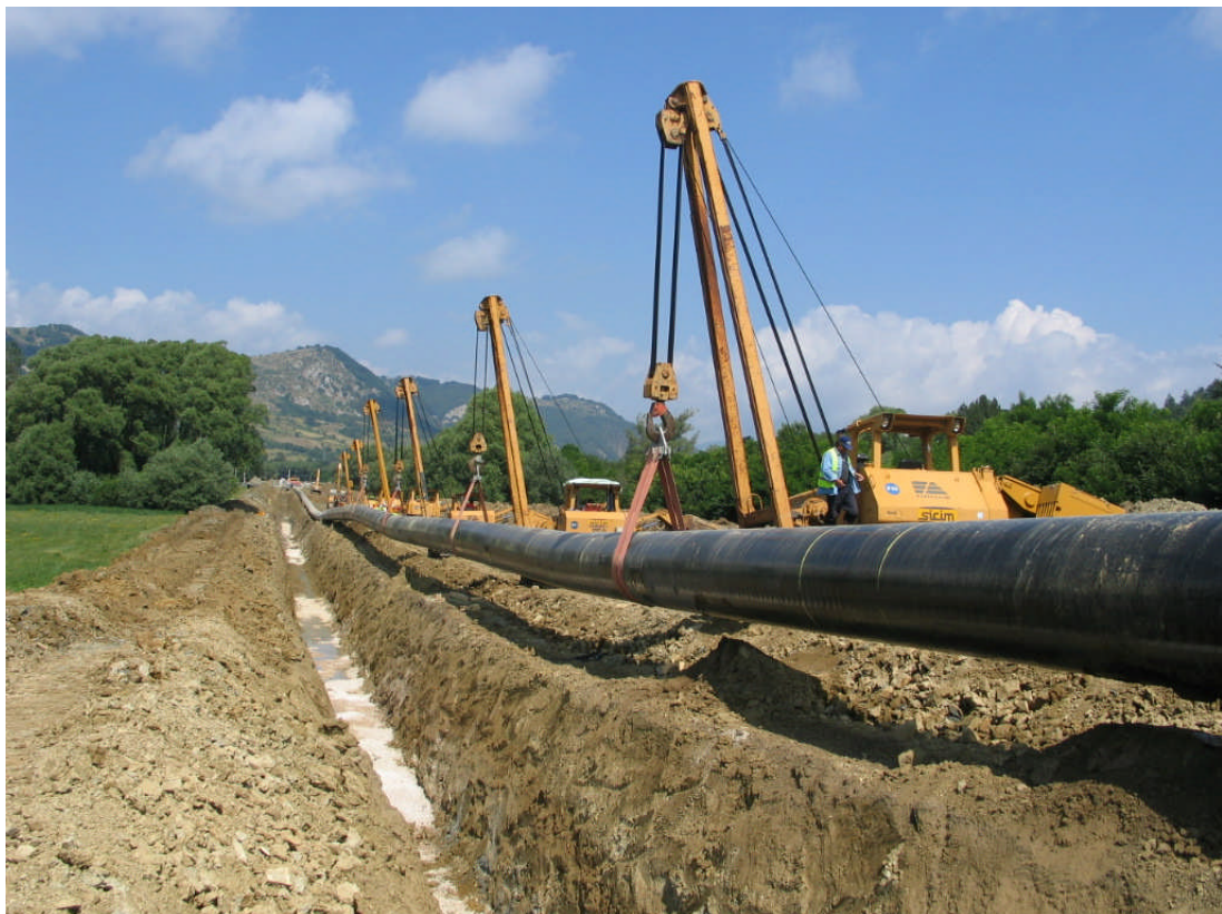
Fig. 5.1/F Posa della condotta
