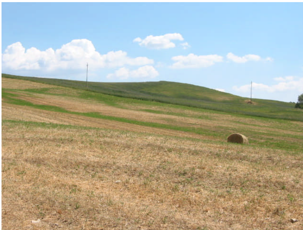
Foto 2.3.1: Area con tipologia di dissesto "Frana per scivolamento-Frana complessa" (km 60,565÷60,735; 60,740÷60,905) - PAI Tevere.
