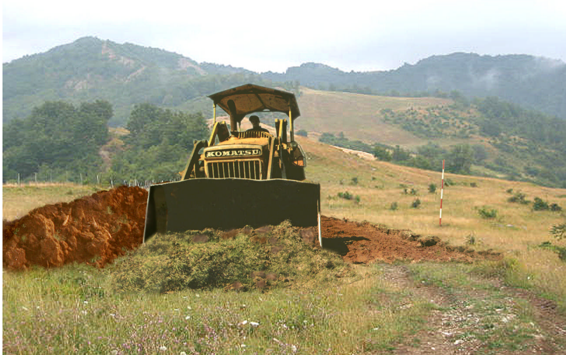
Fig. 4.1/N: Scotico dello strato umico superficiale
