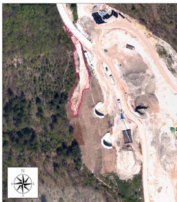
Figura 3 - Ortofoto d'inquadramento del sito "Pista 9" tratto da Google Earth
