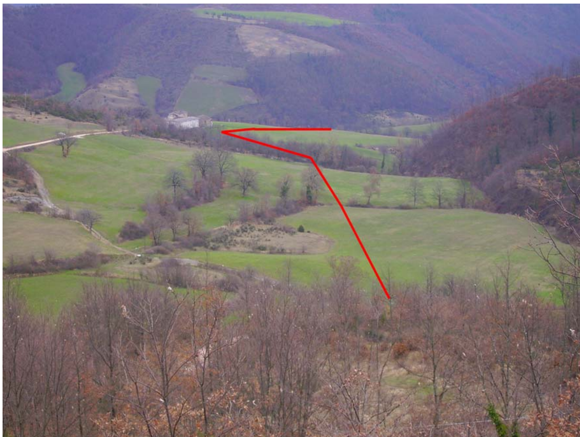
Foto 1/A: Panoramica del tratto in variante, ripreso contro il senso di flusso del gas
