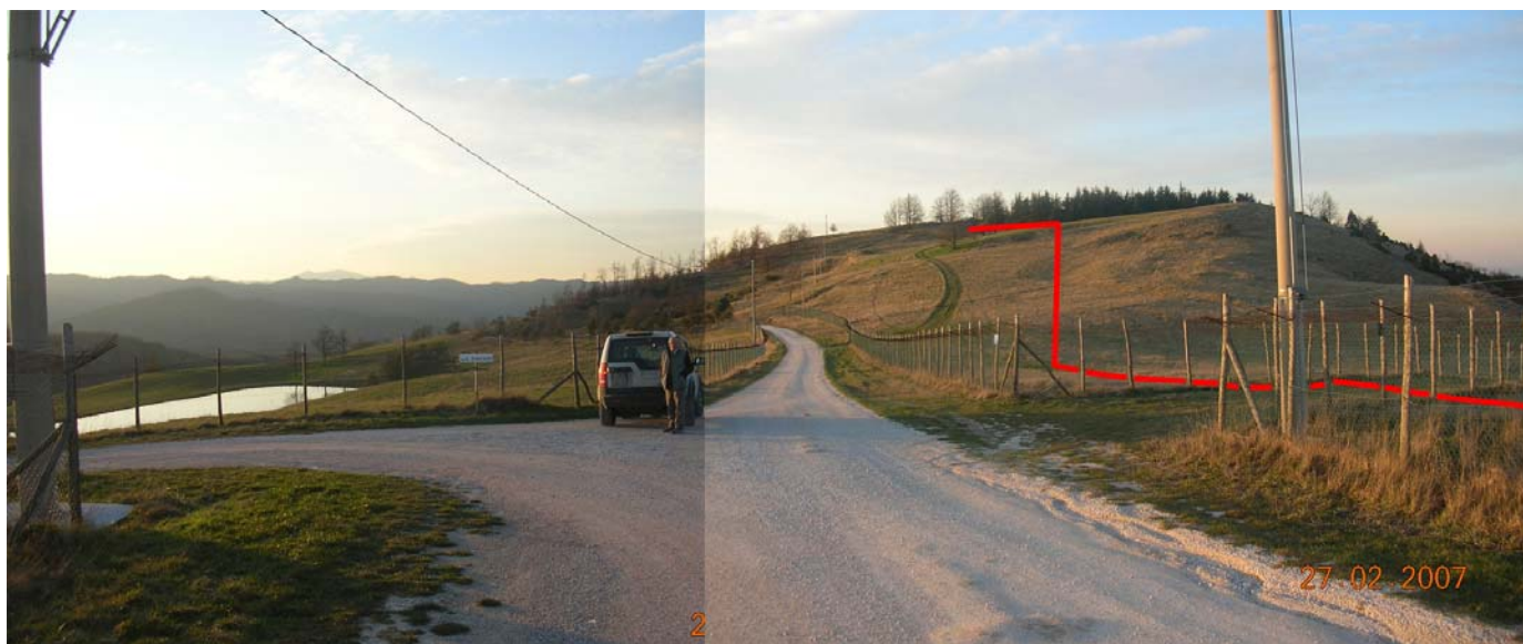
Foto 3.3/A: Tracciato della condotta in corrispondenza del Monte dei Sospiri
