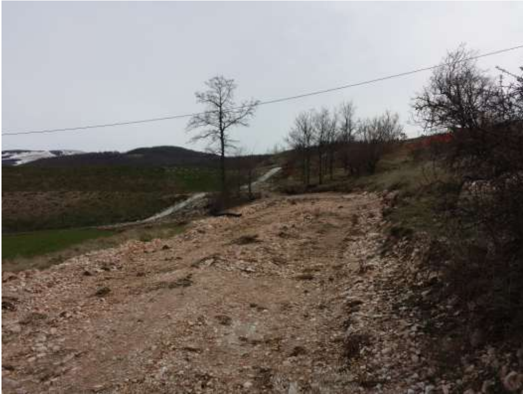
Figura 8 - Immagine della pista in fase di produzione
