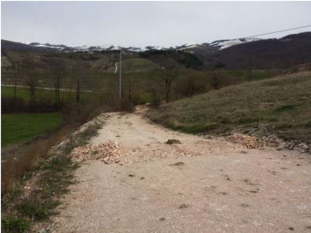
Figura 7 - Immagine della pista in fase di produzione
