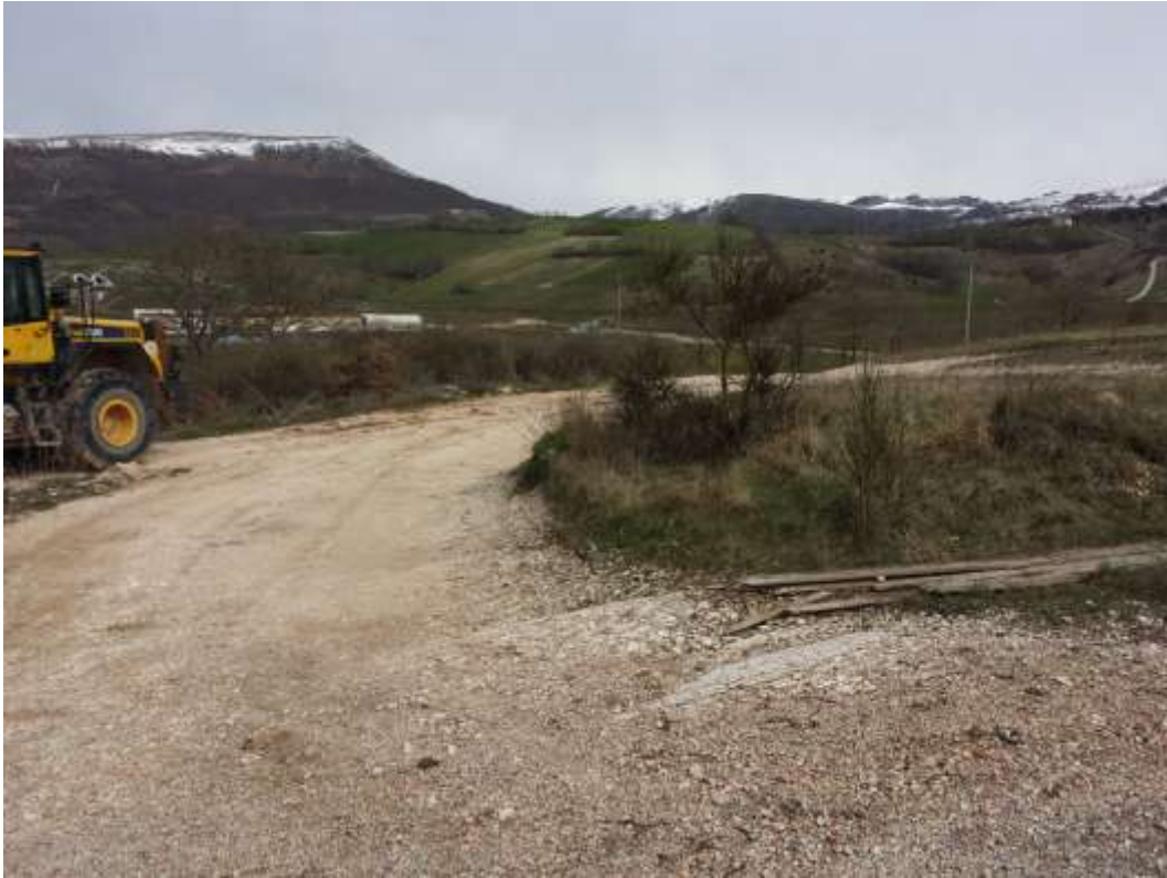
Figura 6 - Immagine della pista in fase di produzione
