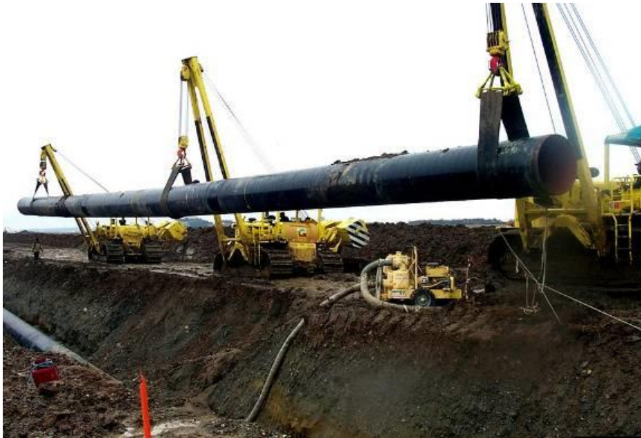
Figura 3-34 - Posa della condotta
