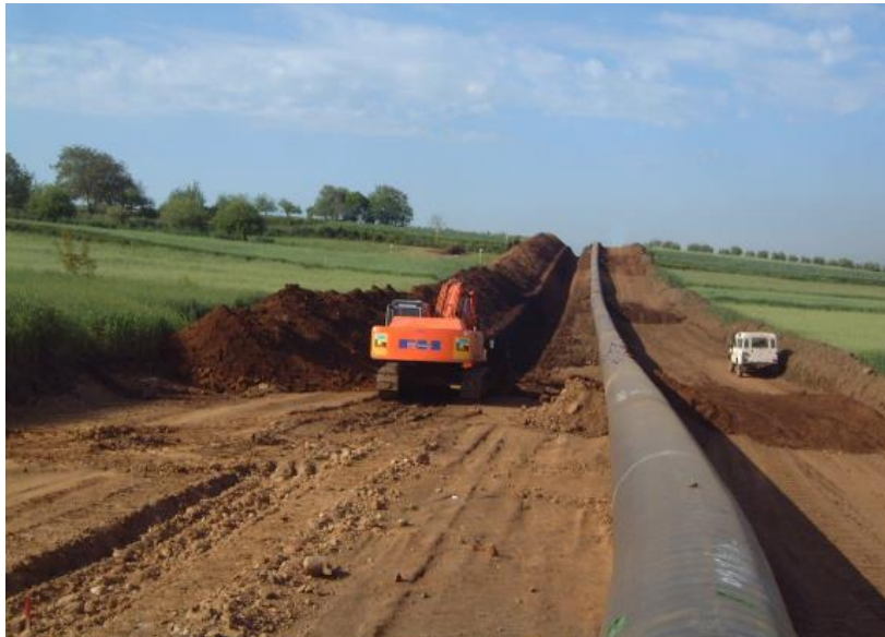
Figura 3-33 - Scavo della trincea
