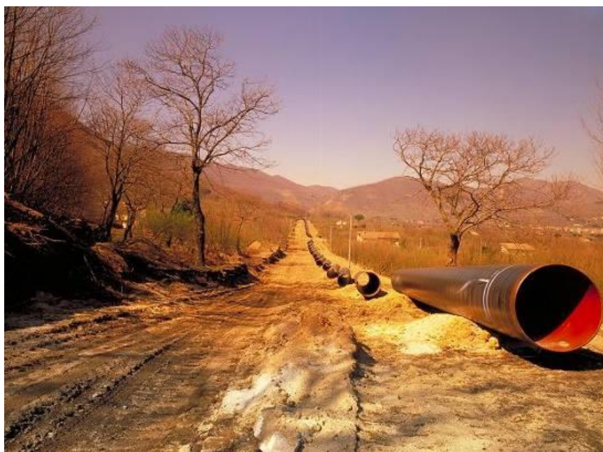
Figura 3-32 - Sfilamento dei tubi
