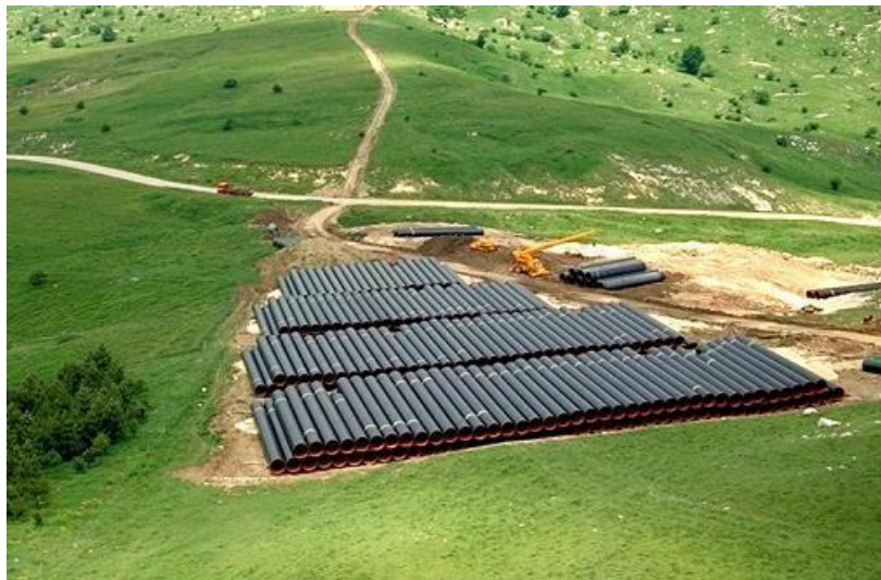
Figura 3-29 - Piazzola di accatastamento tubazioni
