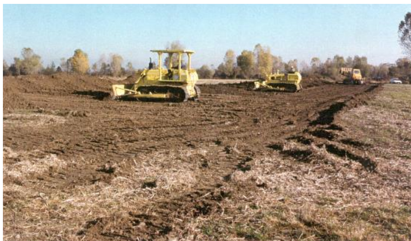
Figura 3-30 - Apertura della pista di lavoro
