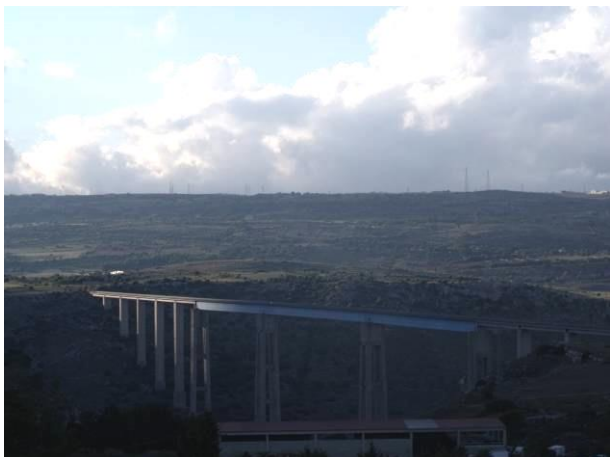
Viadotto sul F. Irminio
