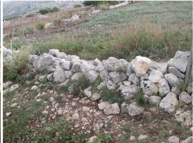
Muretti a secco
