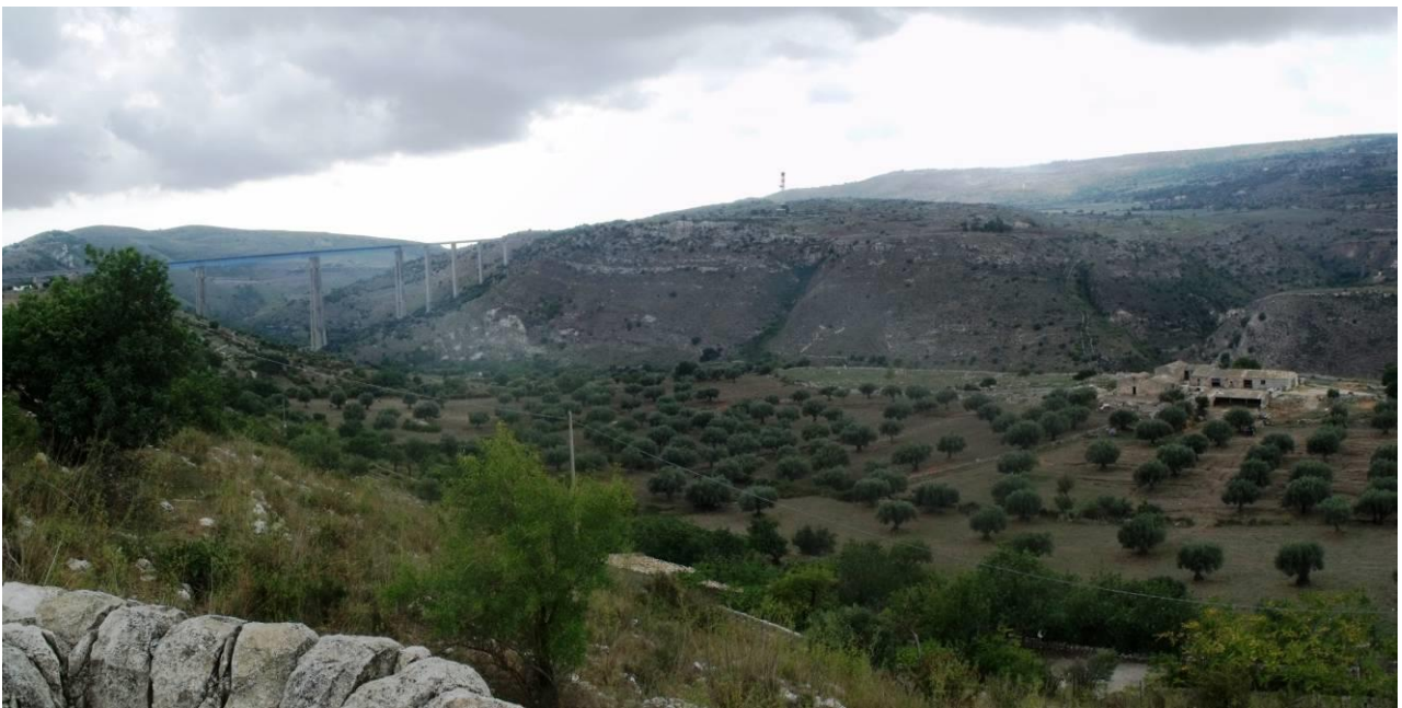
Figura 5-10 – Punto di vista PV3D - SS194 (SS115) Costa del Diavolo: FASE DI PERFORAZIONE MITIGATO
