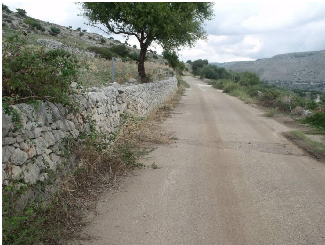
Figura 5-7 – Attraversamento stradale e muretto a secco ricostruito nell'area di studio
