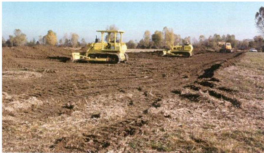
*Figura 9 – Apertura delle pista di lavoro*
