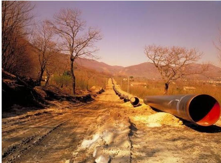
*Figura 11 – Sfilamento del tubo*
