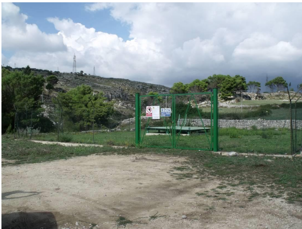
Figura 28 PV4A – Condotta – cameretta D
