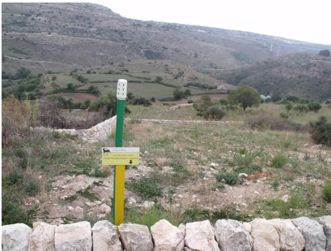
Figura 30 PV4C – Condotta esistente di collegamento Cameretta D – Pozzo Ragusa 15
