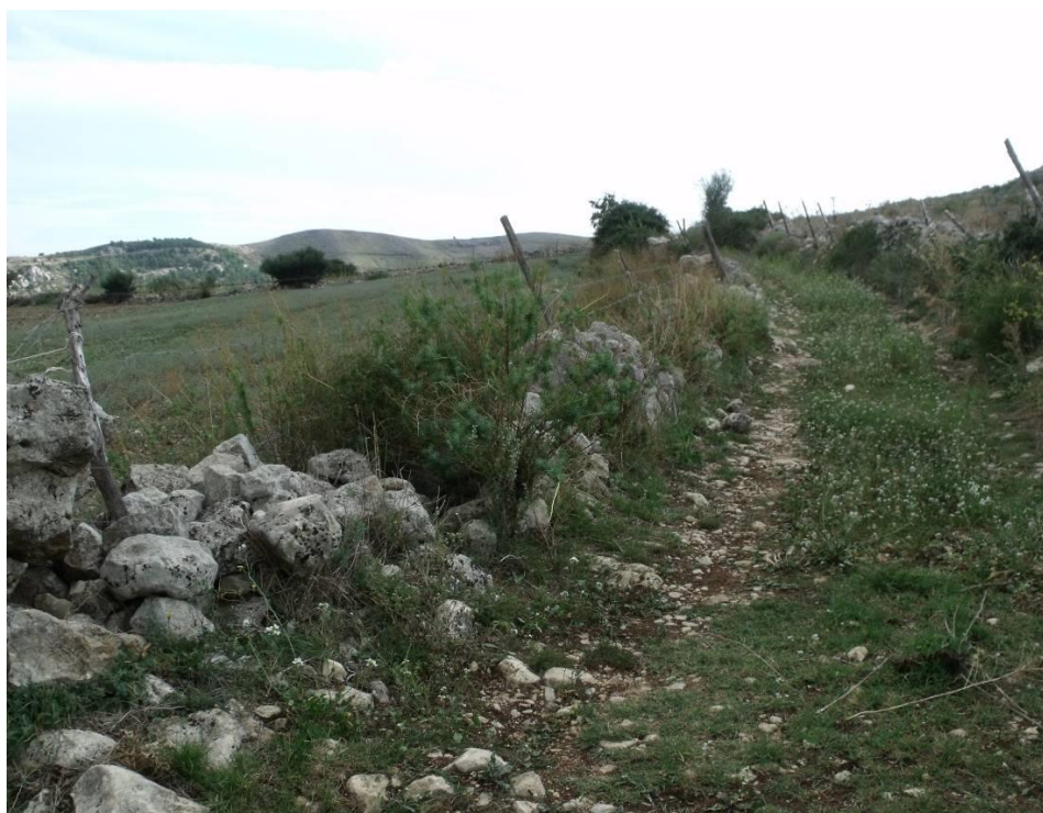
Figura 8 PV2A – Strada di accesso 1 – vista verso sud dall'area pozzo
