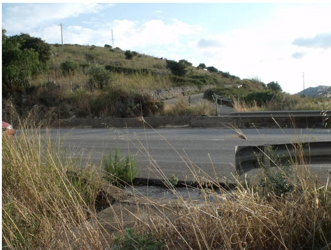
Figura 18 PV2M – Vista dalla Strada di accesso n. 2 alla Strada di accesso n. 1
