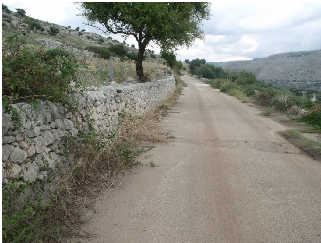
Figura 29 PV4B – Condotta in affiancamento - Attraversamento della condotta esistente di collegamento Cameretta D – Pozzo Ragusa 15
