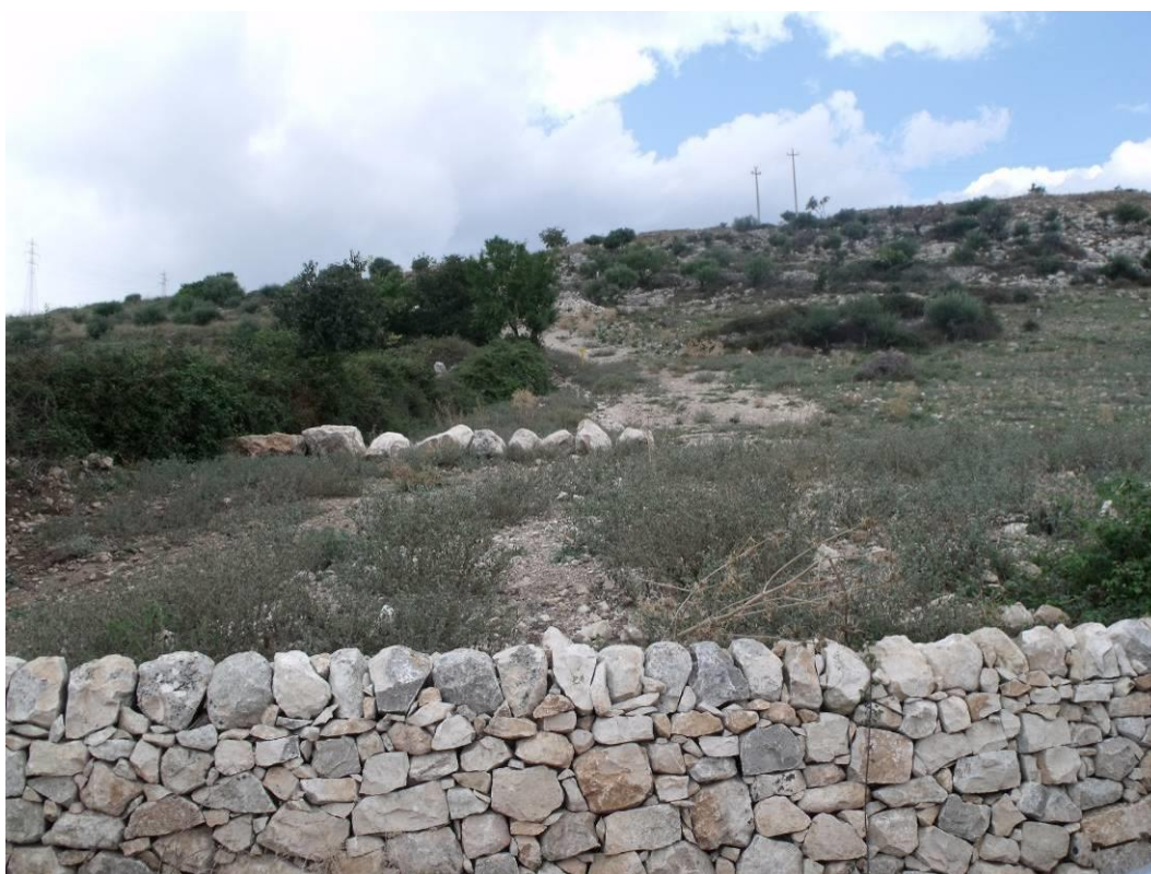
Figura 31 PV4D – Condotta in affiancamento - Condotta esistente di collegamento Cameretta D – Pozzo Ragusa 15
