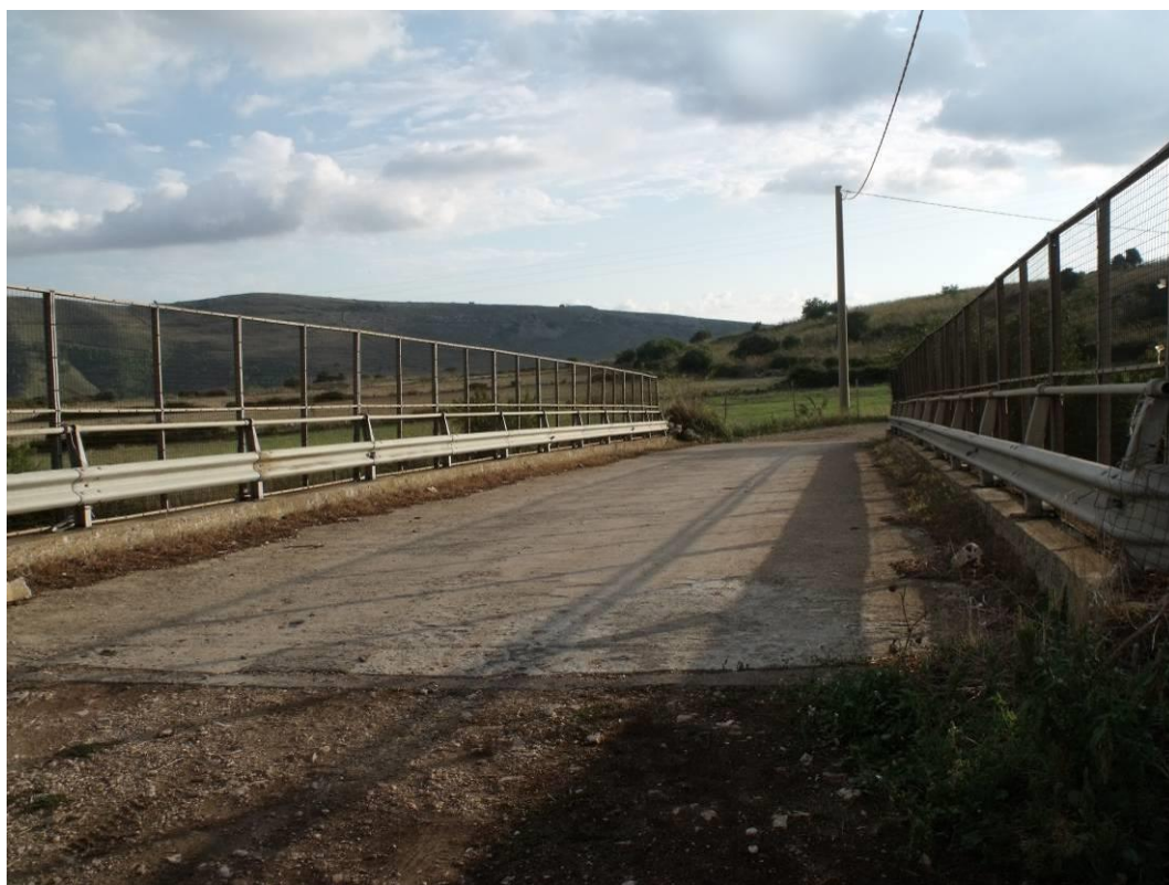
Figura 14 PV2G – Strada di accesso 1 – ponte di accesso a loc. Casa Timparossa
