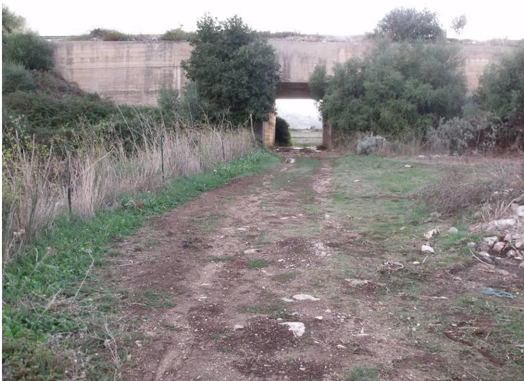
Figura 19 PV2N – Strada di accesso n. 2 – sottopasso
