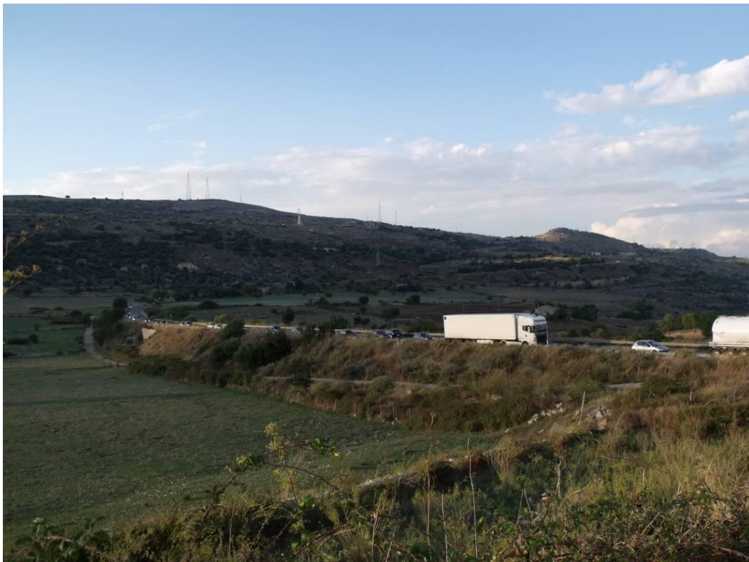
Figura 15 PV2H – Strada di accesso n. 1 in affiancamento alla SS115
