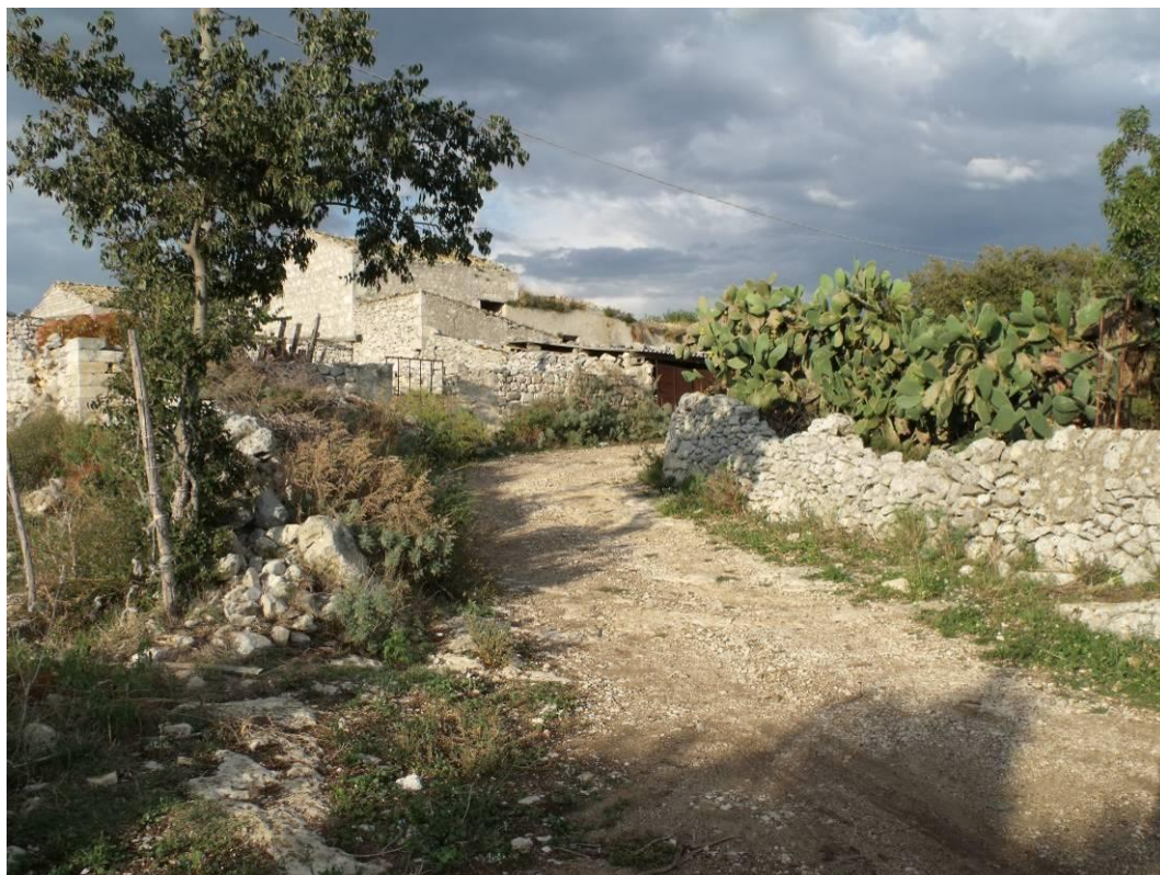
Figura 13 PV2F – Strada di accesso 1 – curva di accesso a loc. Casa Tamparossa
