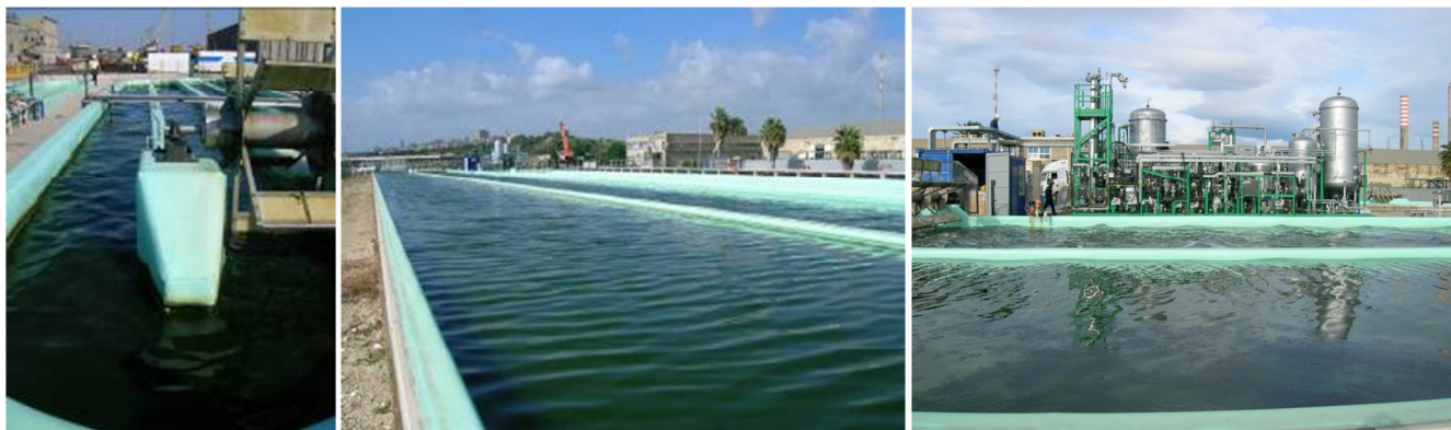
Figura 4. Impianto pilota di Gela: unità di coltivazione microalghe e sezione di recupero bio-olio
