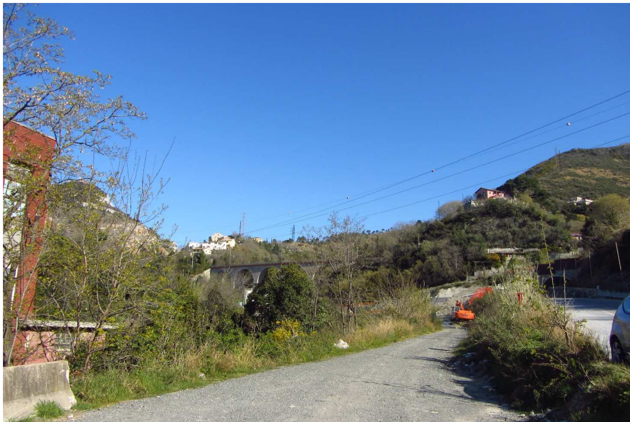
Fig. 1. FAU-GE-030. Particolare della stazione di monitoraggio.
