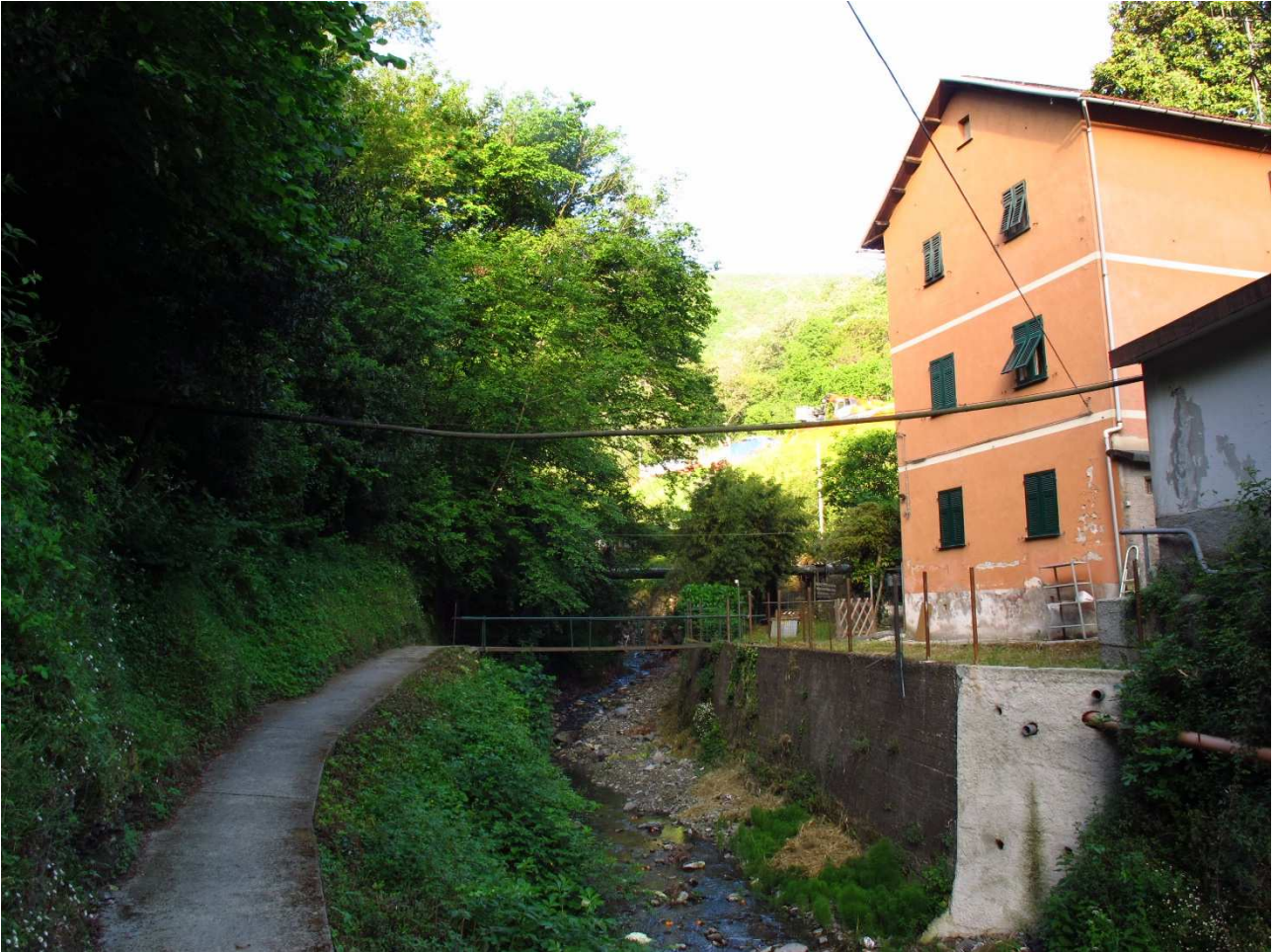
Foto 1. FAU-GE-061. Particolare dell'area di indagine.
