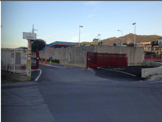
Figura 4-7-- Punto di vista 1°C- Ingresso cantiere CBL3
