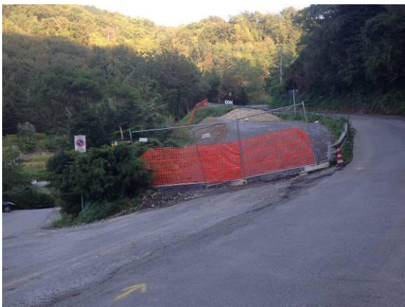
Figura 4-10-- Punto di vista 2°A-S.P.6 vicino ingresso cantiere CBL5
