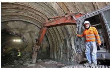
Uno dei cantieri del Terzo Valico
