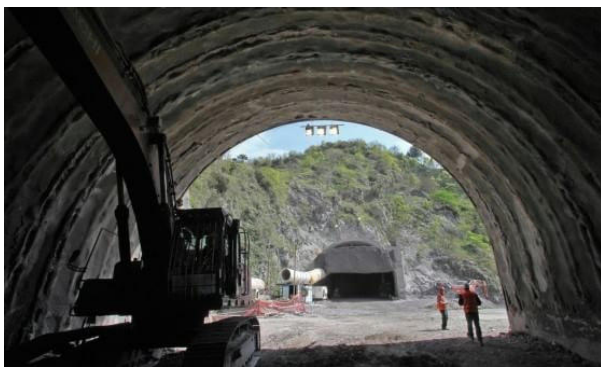
Incidente sul lavoro in un cantiere del Terzo Valico
