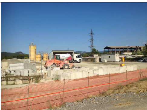
Figura 4-24-- Punto di vista 3°A- Via dei Moriassi
