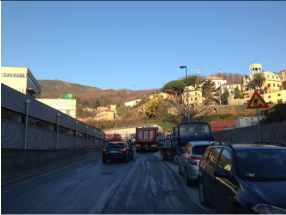
Figura 4-5-- Punto di vista 1°A- ingresso del cantiere COL2
