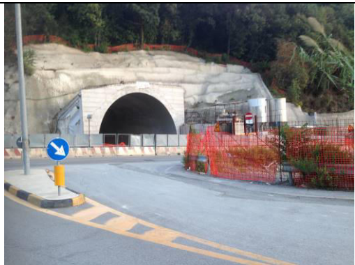
Figura 4-1 – Punto di vista 1°A- cantiere COV1
