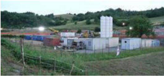
Il cantiere di Radimero, nei pressi di Arquata Scrivia
