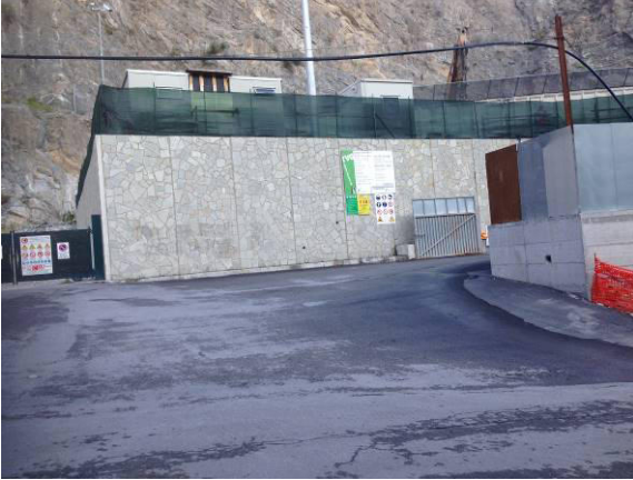
Figura 4-12-- Punto di vista 1°A- Ingresso del cantiere C.S.L.2 lungo la S.P.6
