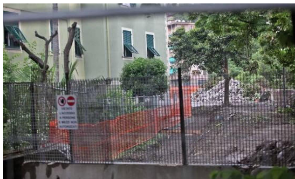
Il cantiere nel giardino sotto la casa di via Coni Zugna
