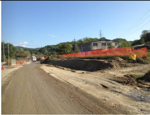
Figura 4-20-- Punto di vista 1°A – Cantiere C.O.P.4- Cascina Radimero
