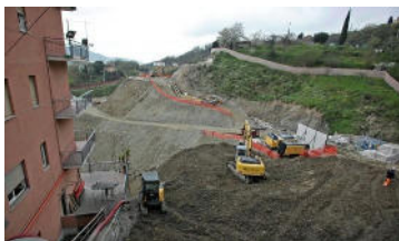
Un cantiere del Terzo Valico
