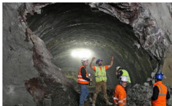
Controlli sulla sicurezza nei cantieri del Terzo Valico
