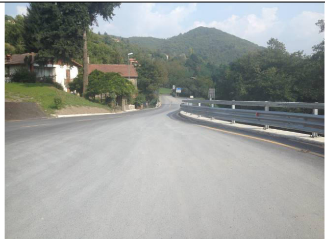
Figura 4-19-- Punto di vista 3°B- Vicino Ingresso Cantiere C.O.P.2 in località Casasse
