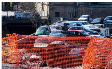
Il demolitore sugli argini del Chiaravagna (leoni)
