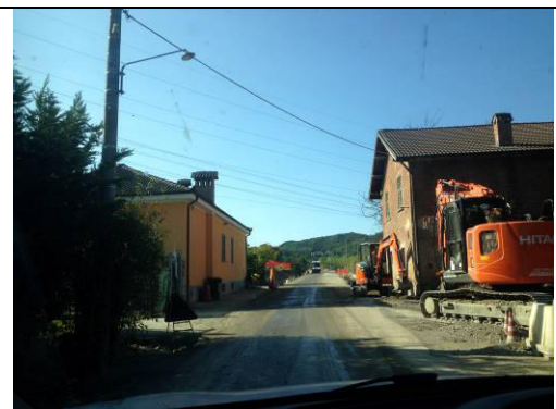
Figura 4-25-- Punto di vista 4°A- Via dei Moriassi
