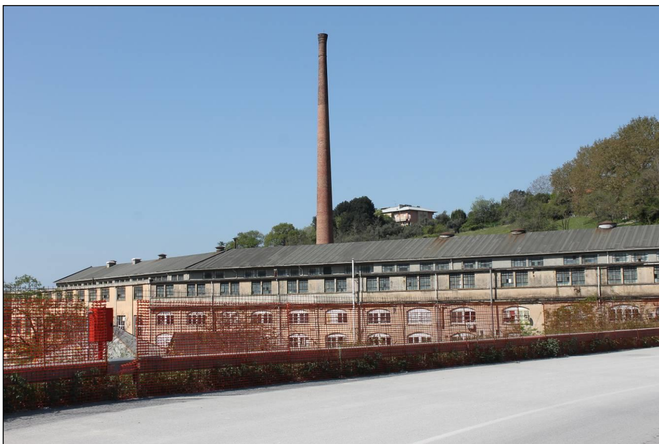
Figura 1 - Area industriale dismessa
