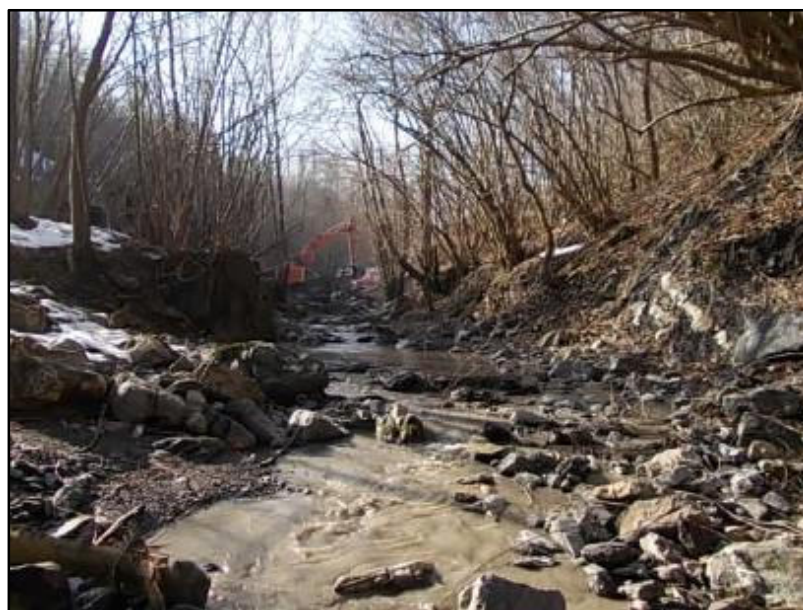
Foto 5.1: Foto della stazione T-FR-010 verso monte (notare i mezzi di cantiere per il movimento terra).
