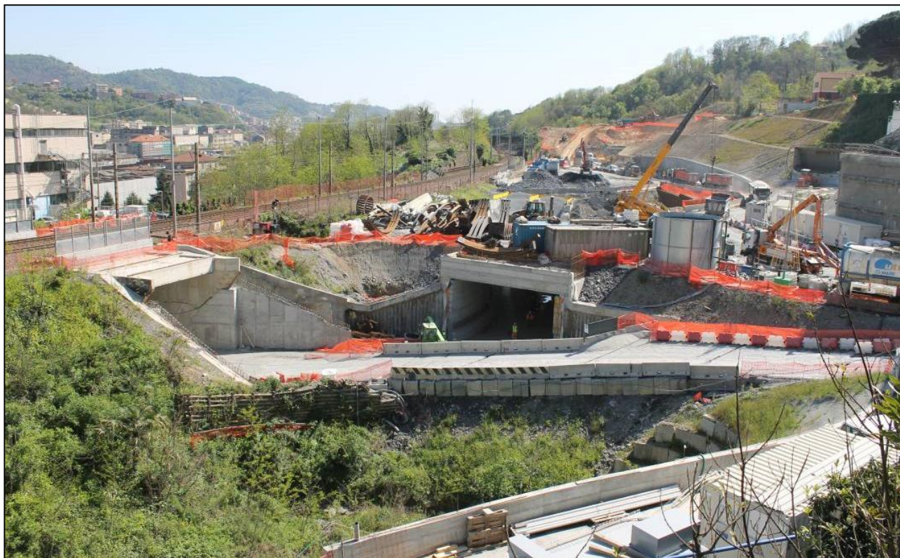
Figura 1 – Area di cantiere
