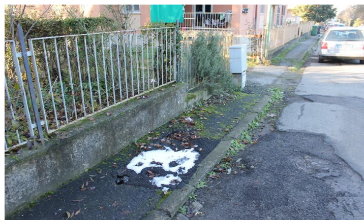
Marciapiede e recinzione
