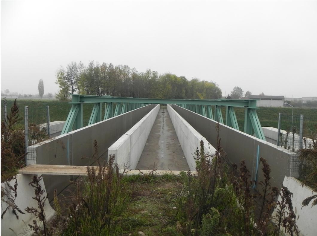
Figura 1-16 – Attraversamento di due canalette irrigue e per pedoni
