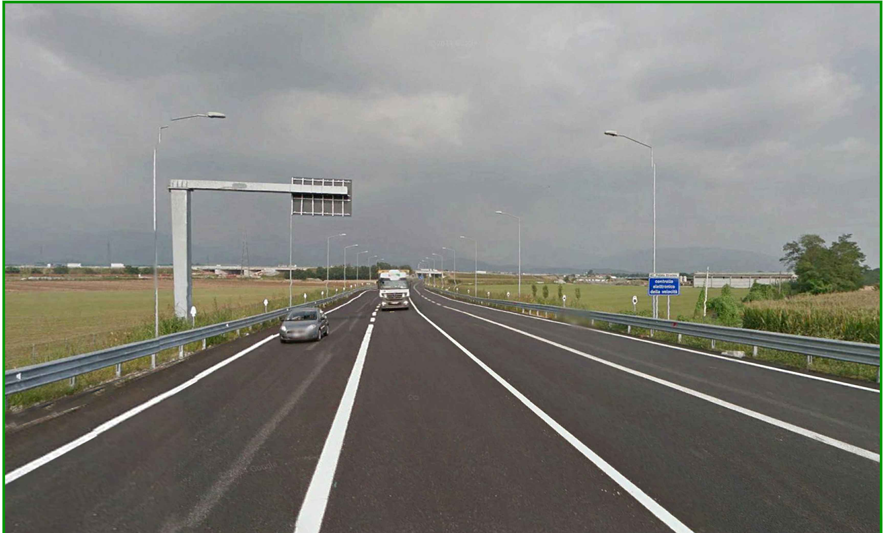
Ante operam - fotografia scattata dal tracciato del raccordo Brebemi-tangenziale di Brescia in direzione Est.
