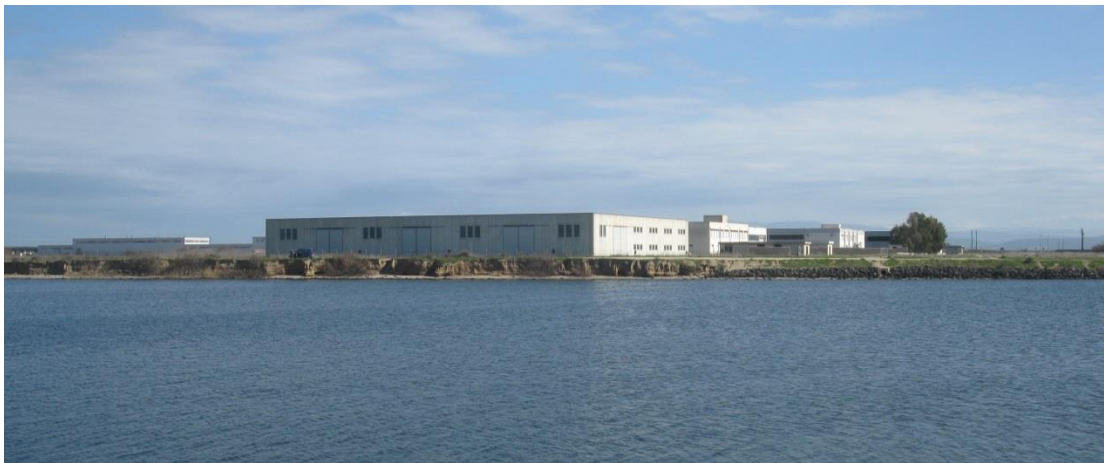
Figura 9.21: Stabilimenti al Confine Sud dell'Area di Progetto
