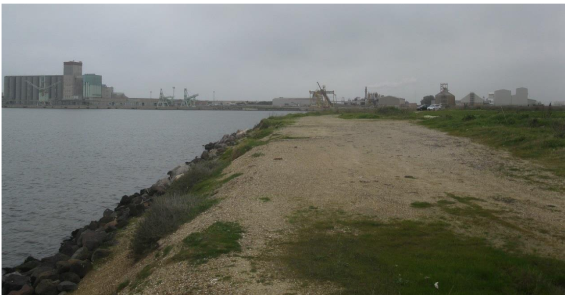
Figura 8.1: Golfo di Oristano, Fascia Costiera compresa nell’Area di Progetto
