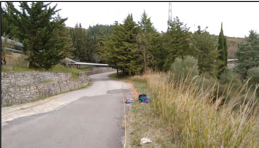
Foto 1: l'area sottoposta ad indagine geofisica. Si notano sulla sinistra della carreggiata le gabbionate realizzate nel passato a protezione della carreggiata
