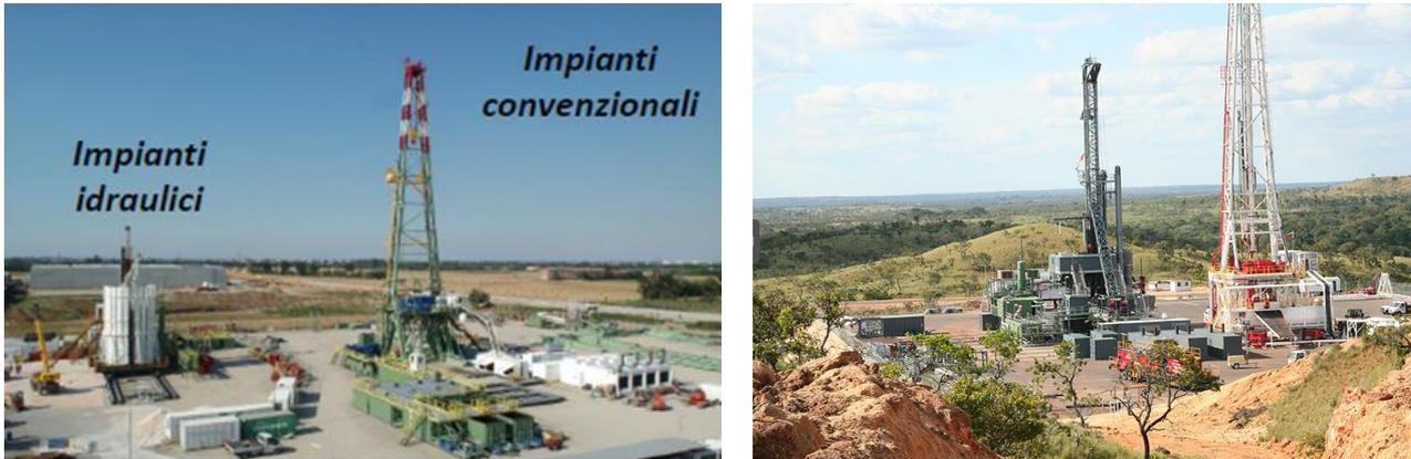
Figura 25: Confronto impianti di perforazione idraulici e convenzionali (fonte: [www.drillmec.com](http://www.drillmec.com) e [www.bauerdeepdrilling.com](http://www.bauerdeepdrilling.com))
