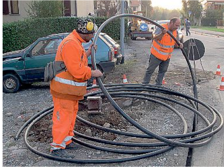
CANTIERI Operai al lavoro per la banda larga. Presto l'intero Valdarno sarà connesso, comprese le frazioni
