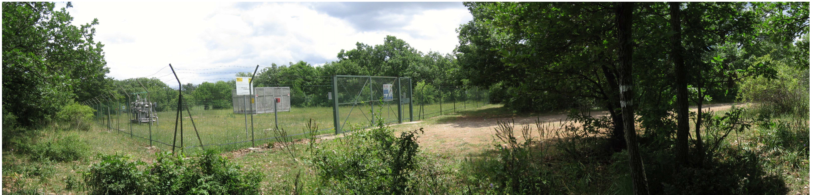
FOTO 6 : Vista del pozzo GR 26
