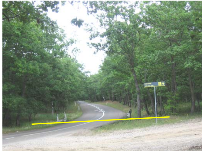
Ripresa 2: attraversamento interrato della condotta
