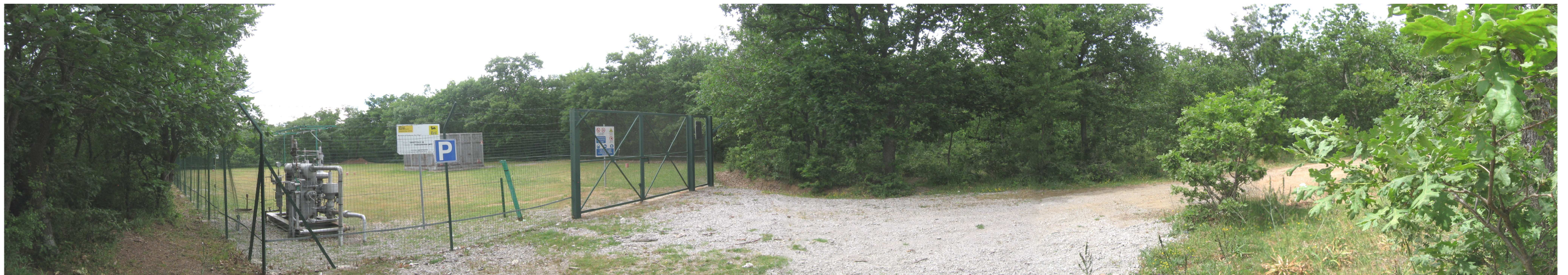
FOTO 2 : Vista del pozzo GR 28
