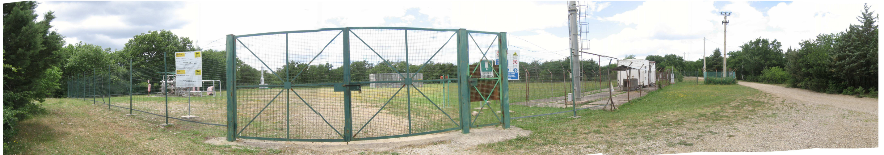
FOTO 3 : Vista del pozzo GR 36 - 37
