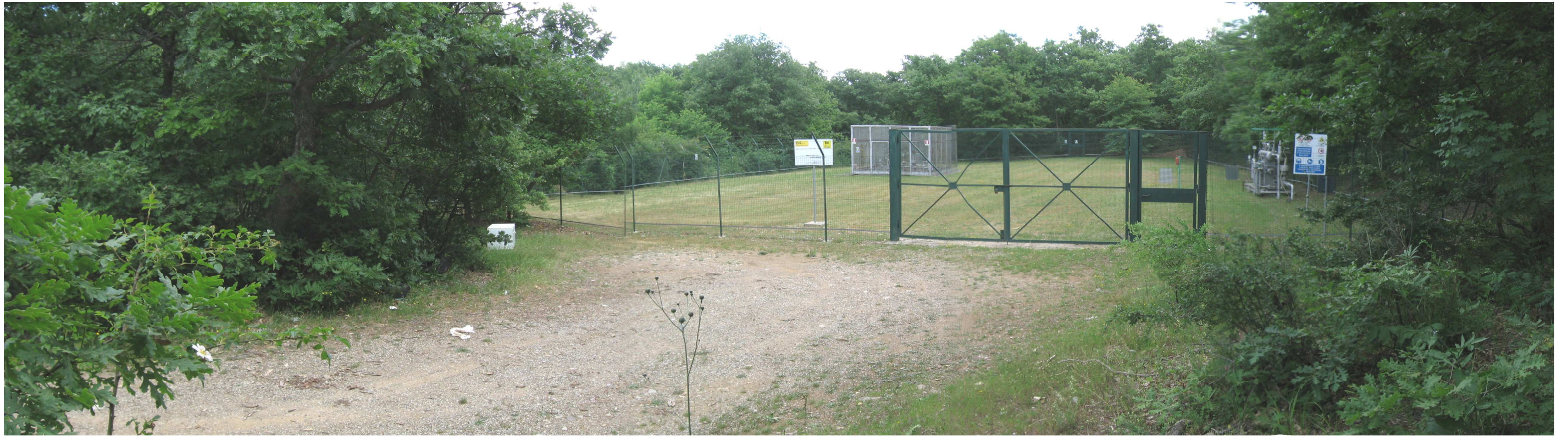
FOTO 7 : Vista del pozzo GR 23
