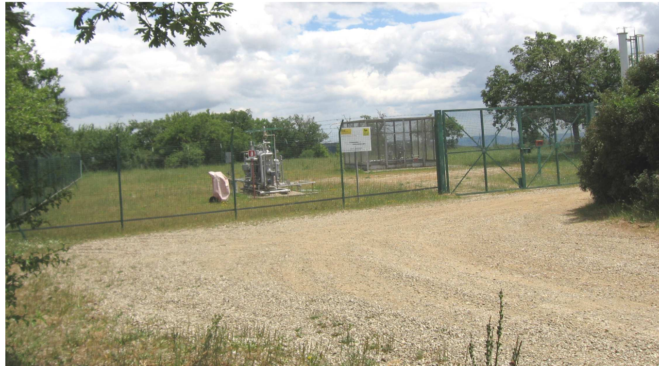
FOTO 5 : Vista del pozzo FE 17
