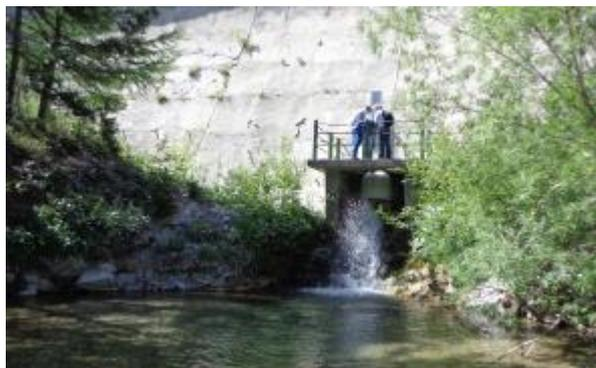
Figura 40 - Panoramic dello scarico di fondo della diga. La sponda destra è soggetta ad erosione per effetto dei flussi rilasciati.
