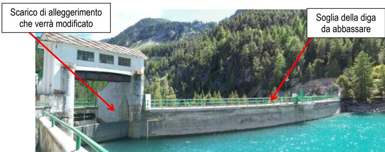
Figura 35 – Panoramica dell'opera di sbarramento da monte. Gli interventi previsti sulle strutture esistenti prevedono l'abbassamento della diga e la realizzazione di un nuovo scarico di alleggerimento e di fondo.
