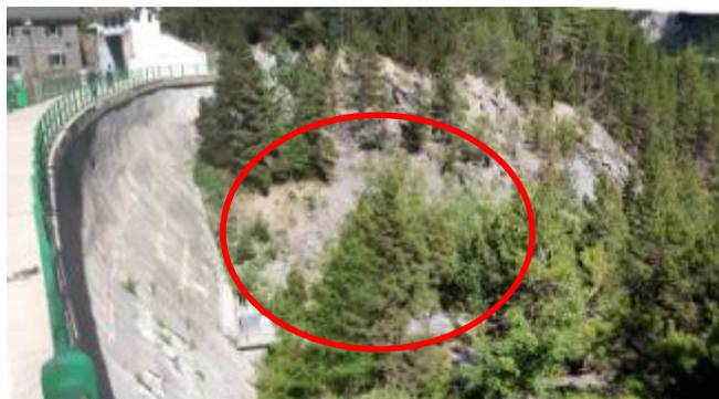
Figura 41 - Panoramic della sponda sinistra a valle della diga. La coltre detritica è potenzialmente soggetta a dissesto per azione dei flussi rilasciati dallo scarico di fondo.
