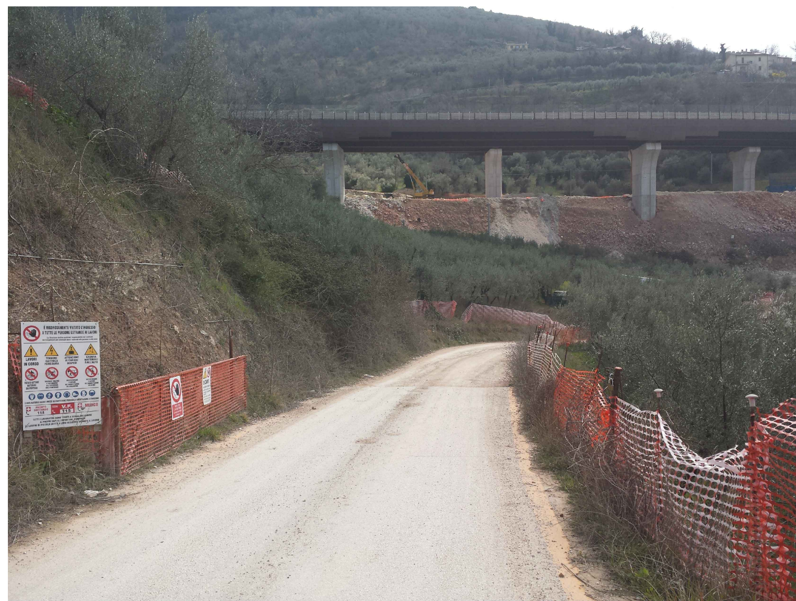
FOTO 2: Vista tratto iniziale della strada di cantiere esistente
