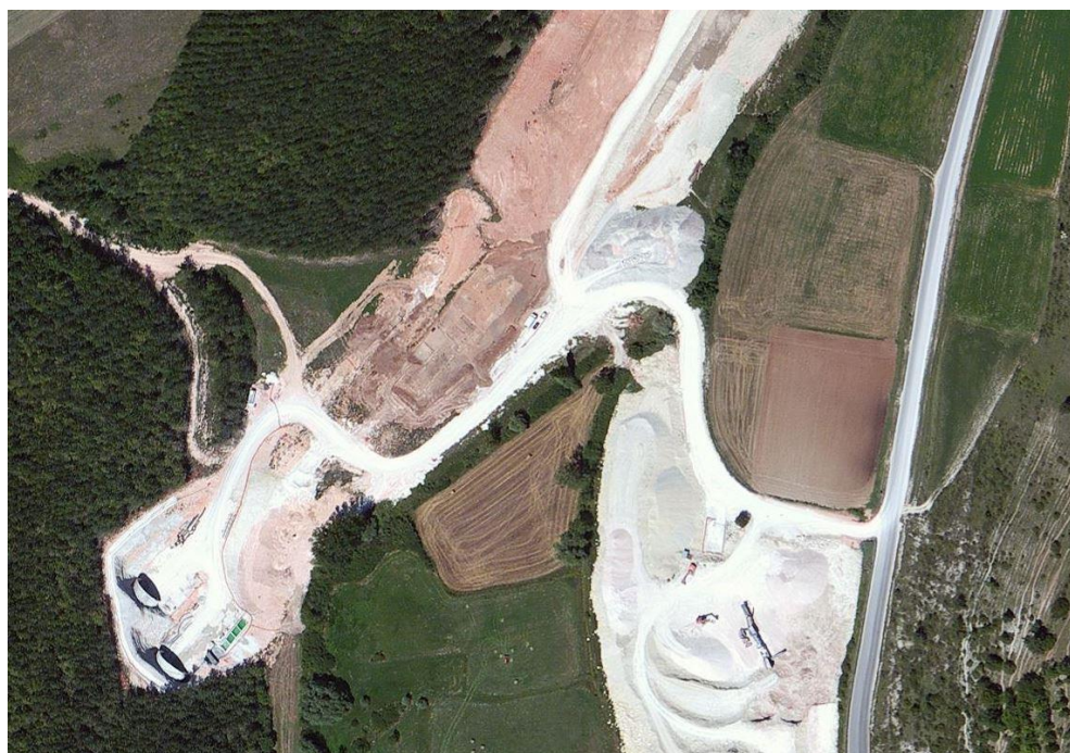
Figura 3 - Ortofoto d'inquadramento del sito "Pista 15" tratto da Google Earth
