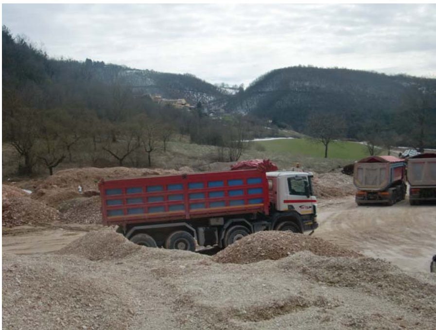
Figura 7.a - Immagine dell'area in fase di cantiere
