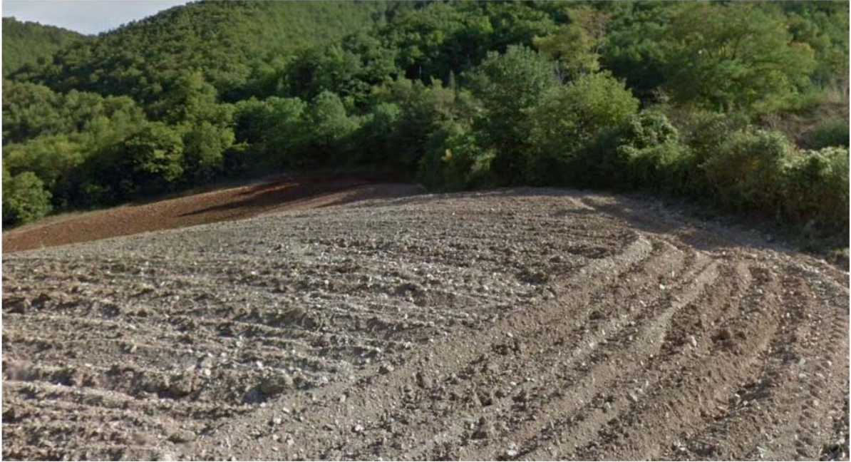
Figura 4 – Immagini dell’area di cantiere Ante Operam
