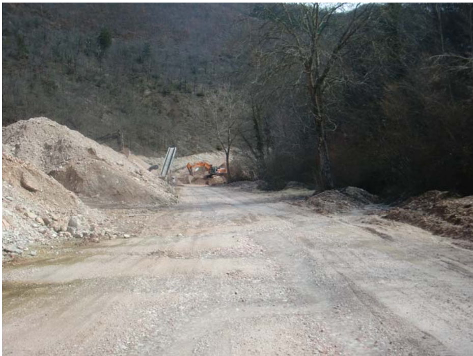
Figura 7.c - Immagine dell'area in fase di cantiere
