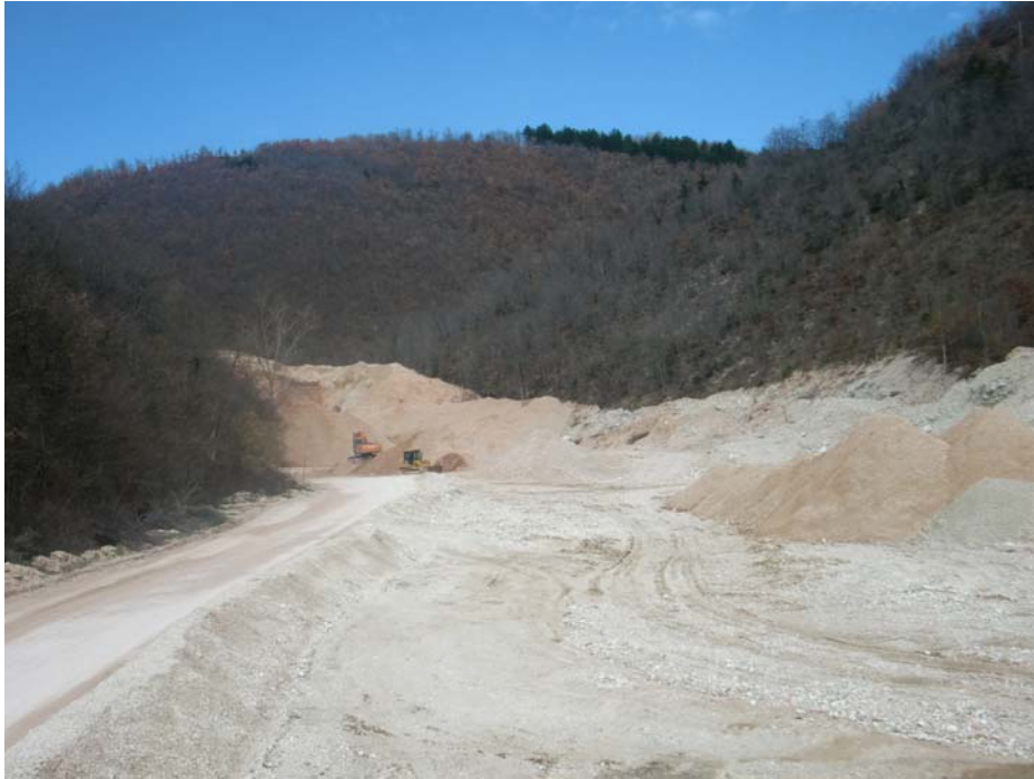
Figura 7.b - Immagine dell'area in fase di cantiere
