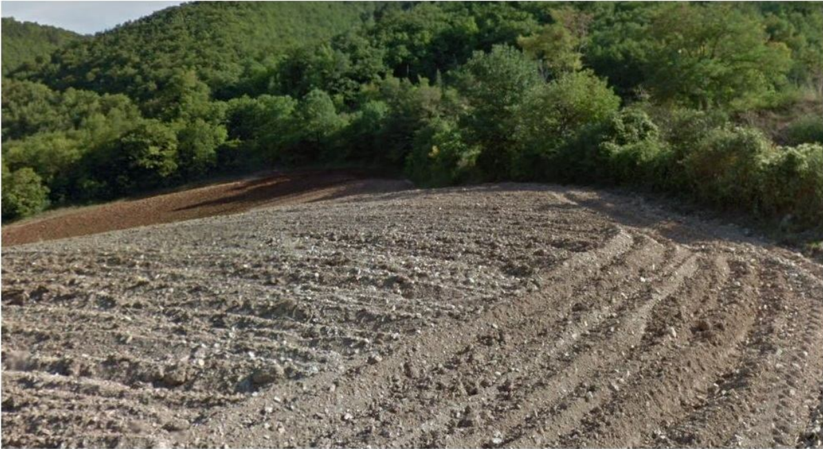
Figura 6 – Immagine dell'area di cantiere Ante Operam .
