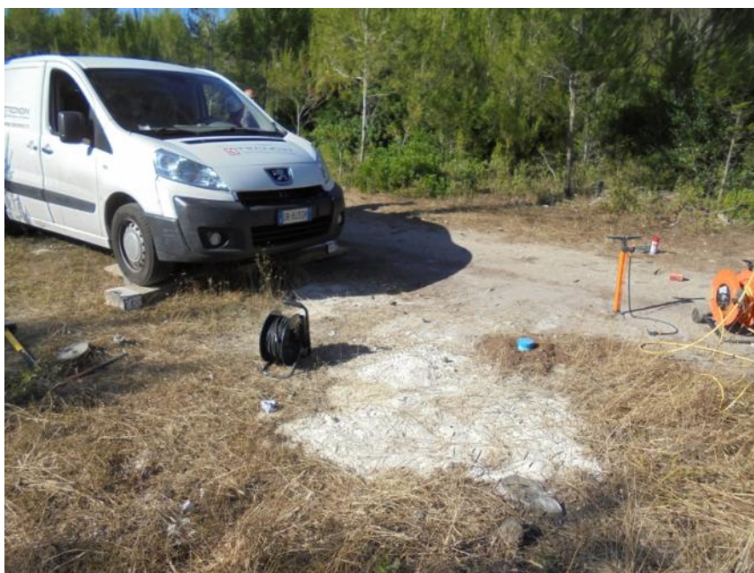
Foto 13 - Melendugno. TAP. Prospezione down-hole. DH-1 sondaggio ST_BH4.
