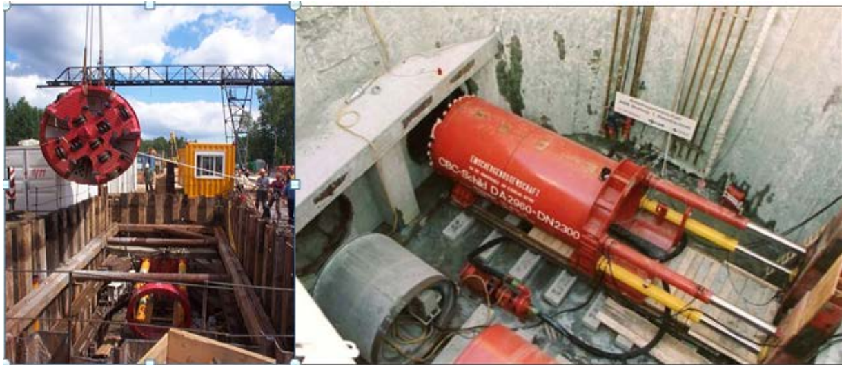
Figura 13-4- Installazione della TBM
