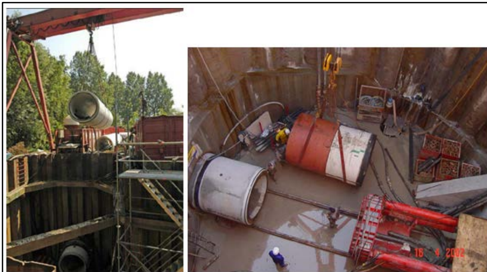
Figura 13-1: -Installazione conci
