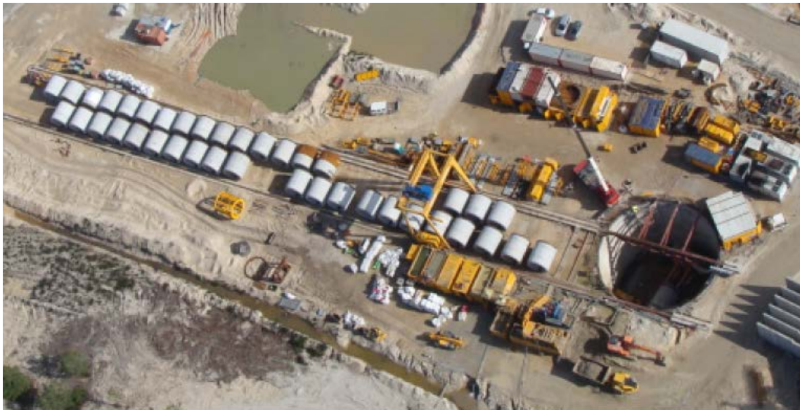
Figura 12-8- Tipico cantiere di costruzione di microtunnel.
