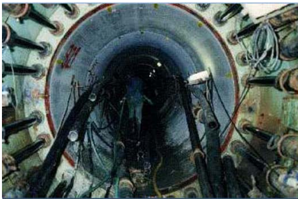
Figura 13-7- Immagine fotografica e schema (da Fornitore internazionale) di una stazione di spinta intermedia
