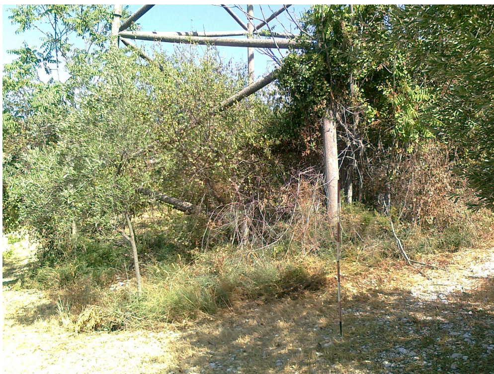
Fig. 15. Palo 34 visto da SE
