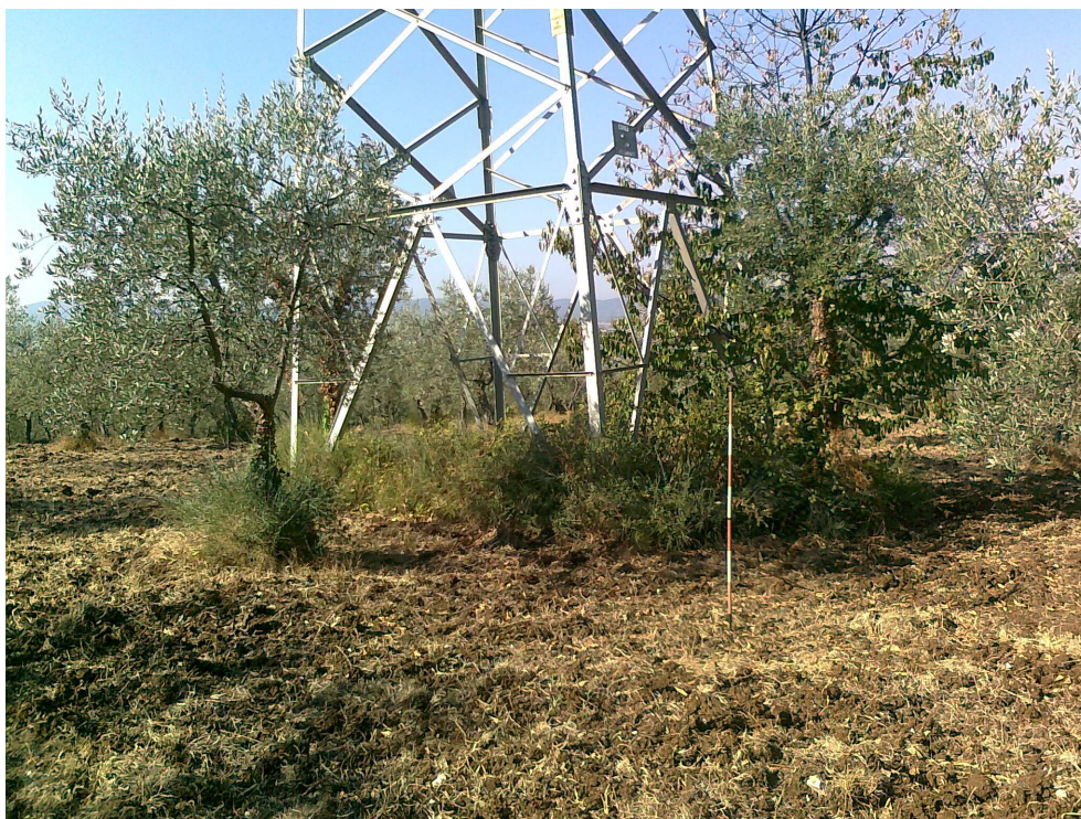
Fig. 1. Palo 21 visto da NE
