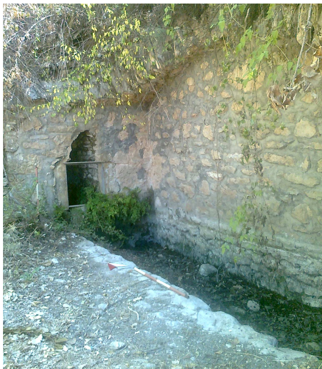
Il cunicolo in muratura visto da sud
