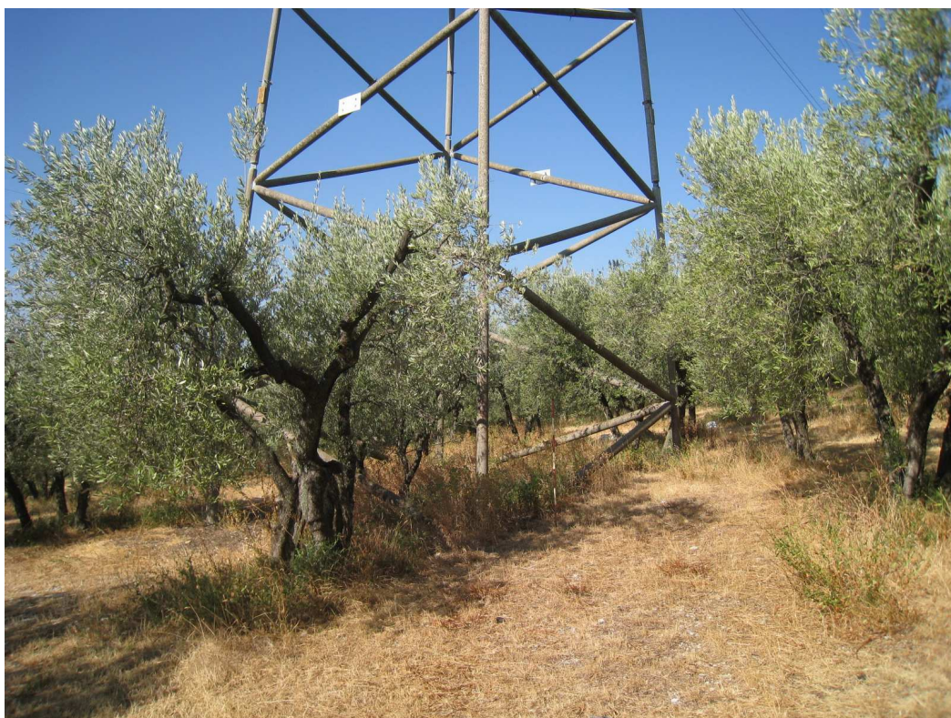
Fig. 4. Palo 23 visto da NE
