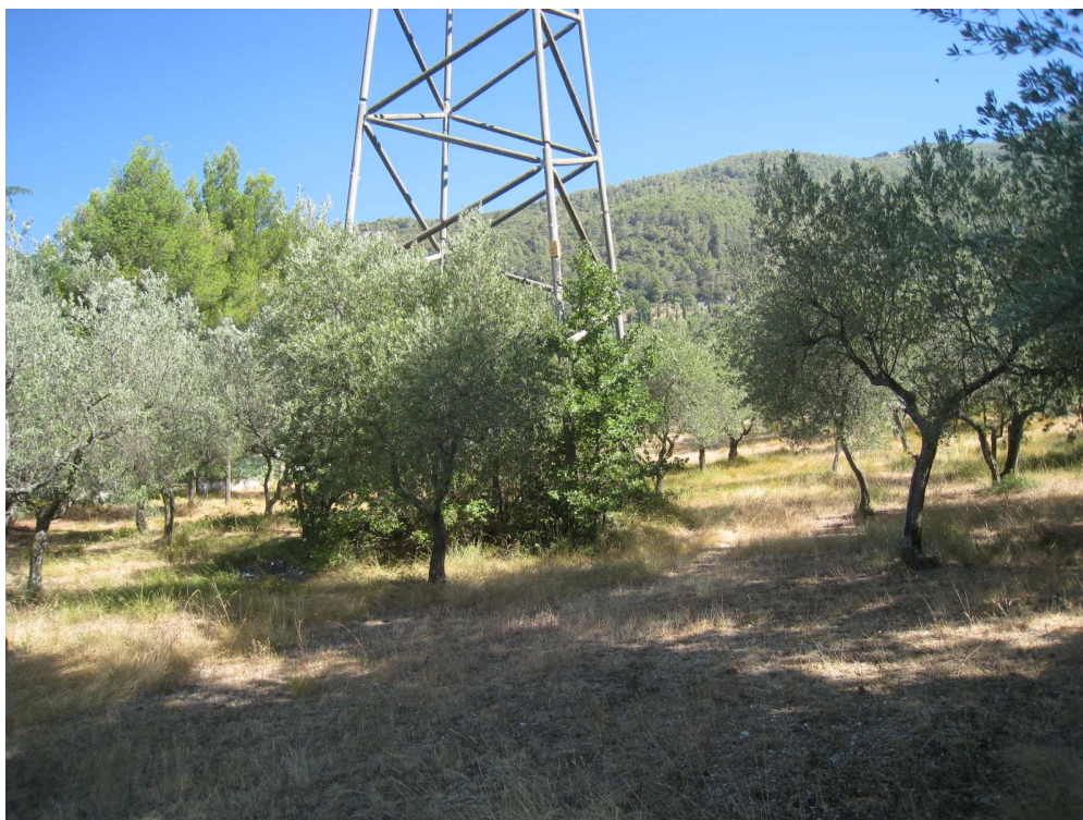
Fig. 3. Palo 22 visto da SE
