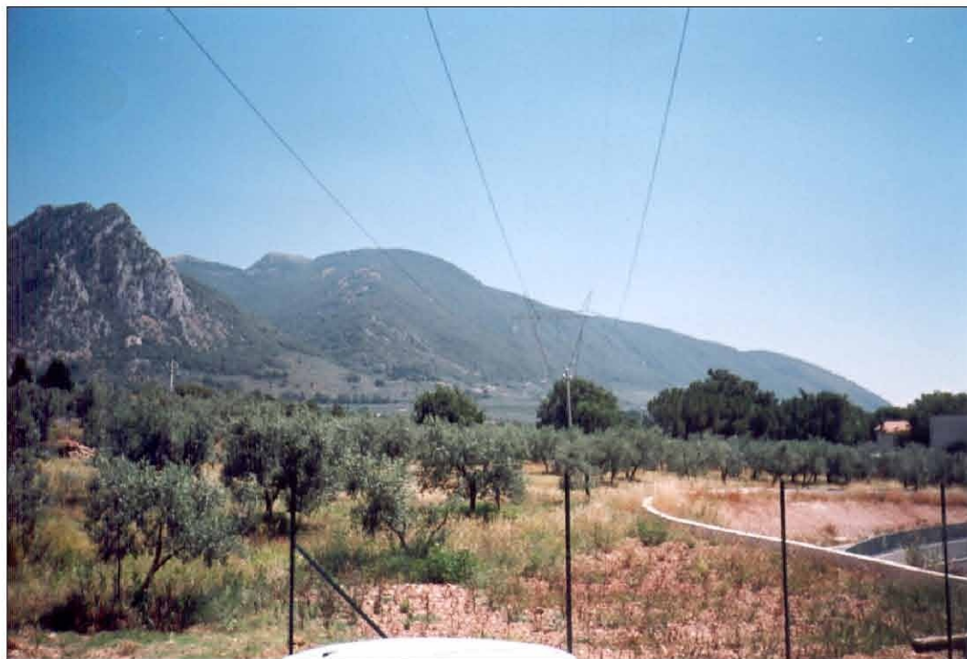
Foto n. 8 - Tratto dell'elettrodotto da demolire che s'immette nell'area urbana.
