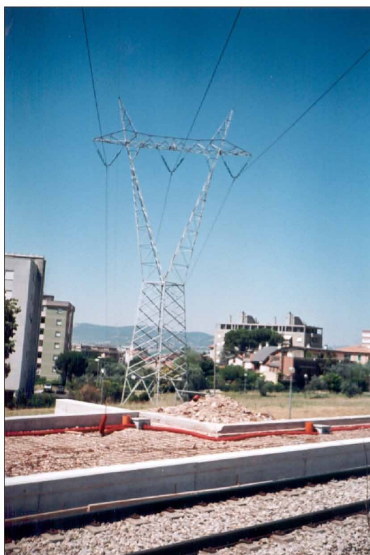
Foto n. 5 - Tratto dell'elettrodotto da demolire che attraversa la città.
