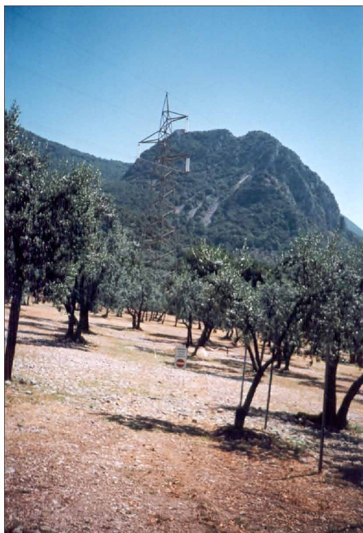
Foto n. 2 - Alle spalle del Traliccio (da sostituire) si nota la catena dei Monti Martani.
