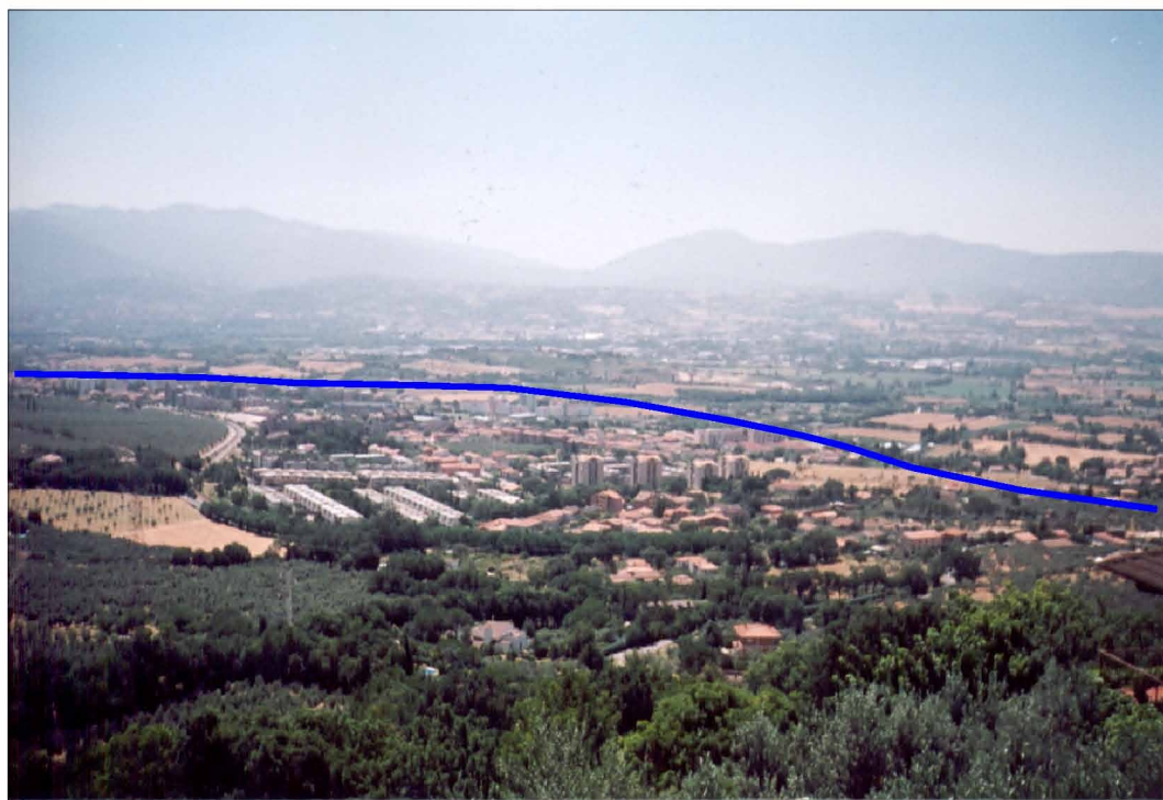
Foto n. 1 - Tratto dell'elettrodotto da demolire che attraversa la città.
