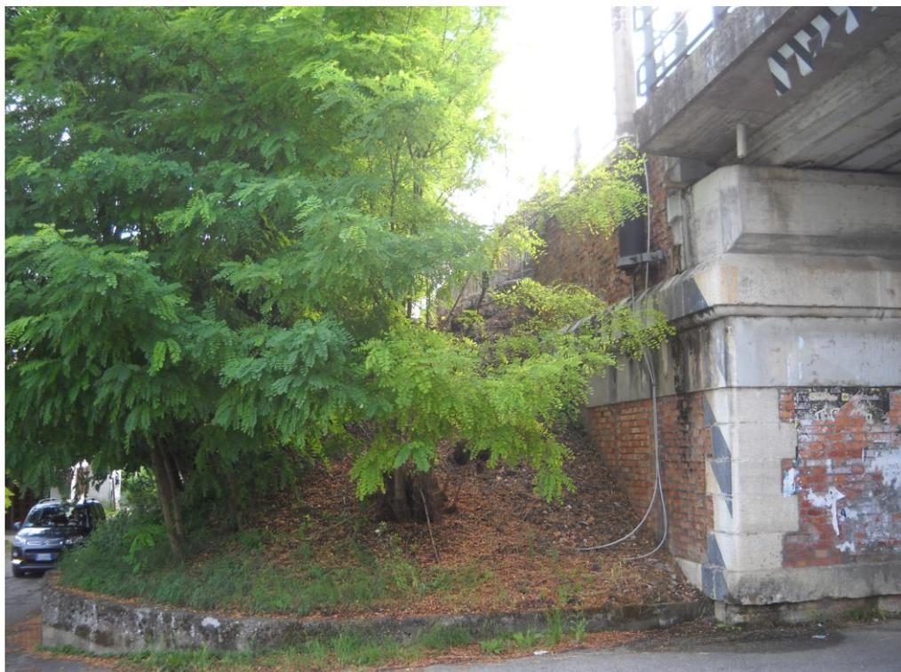
Foto n° 10 Muro di sottoscarpa da demolire
