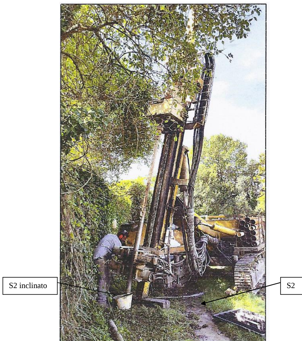
Foto 13 – Sondaggio S2 e S2 inclinato (S3)
