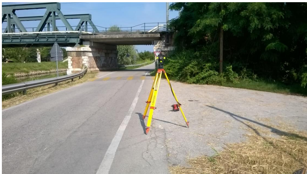
Figura 5-2 Materializzazione del punto 1000 della poligonale
