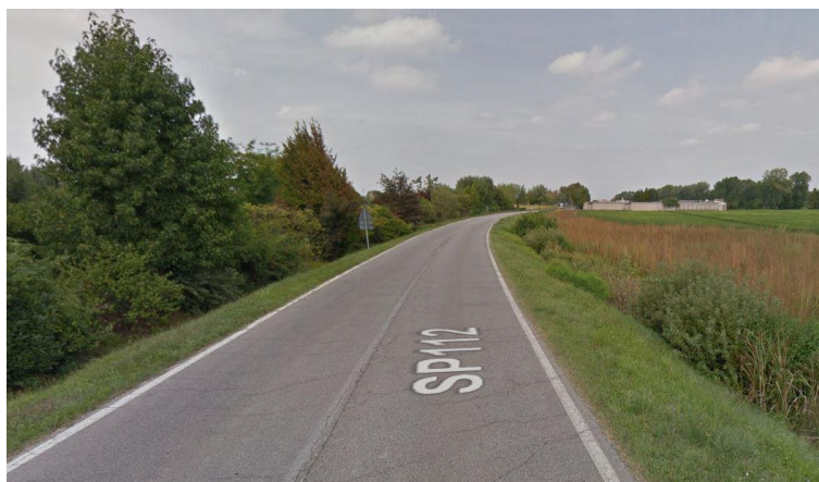
Figura 6-1 Vista della sede stradale della S.P.112
