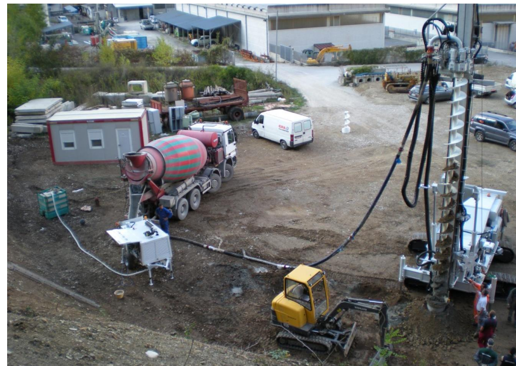
Figura 3-7: organizzazione di un cantiere con tecnologia CFA
