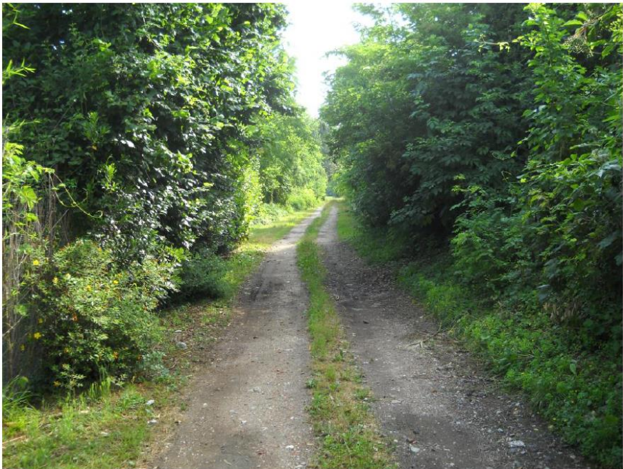
Figura 3-3: strada poderale al piede del rilevato esistente
