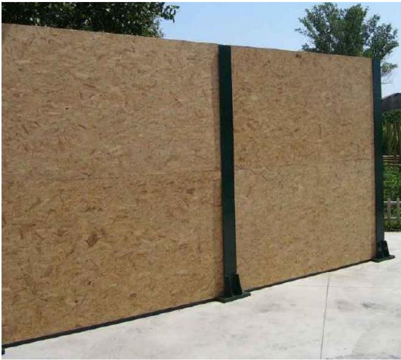
Figura 6-2: recinzione di cantiere con pannelli tipo OSB
