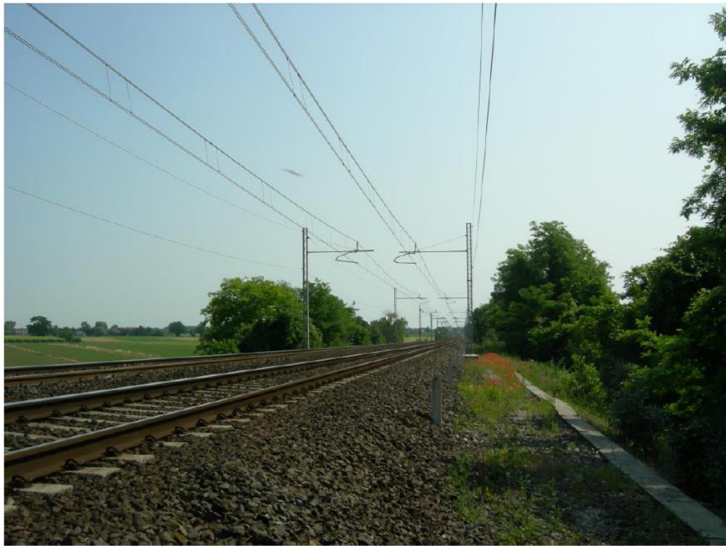
Figura 3-4: rilevato ferroviario allo stato attuale
