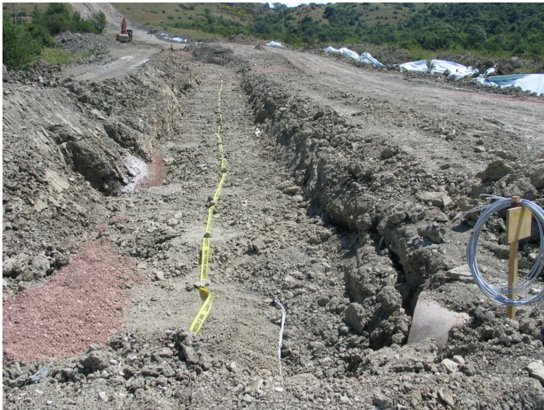
Foto 5.1/G: Rinterro della condotta
