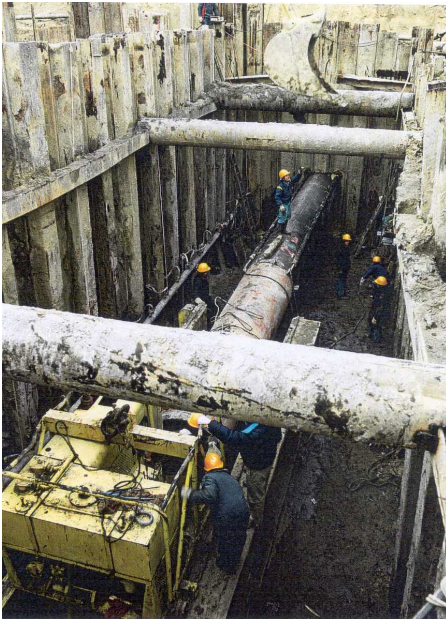
Foto 5.1/l: Trivellazione con spingitubo
