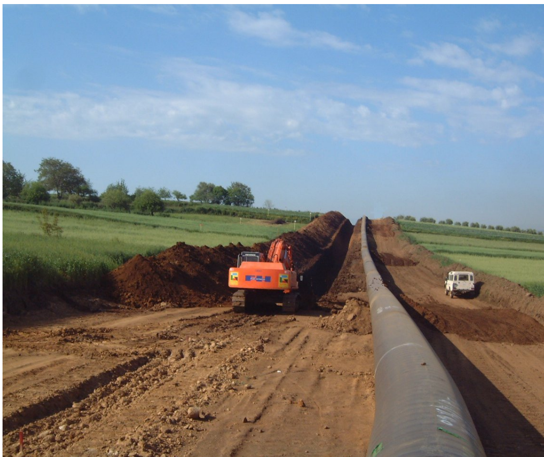
Foto 5.1/D: Scavo della trincea
