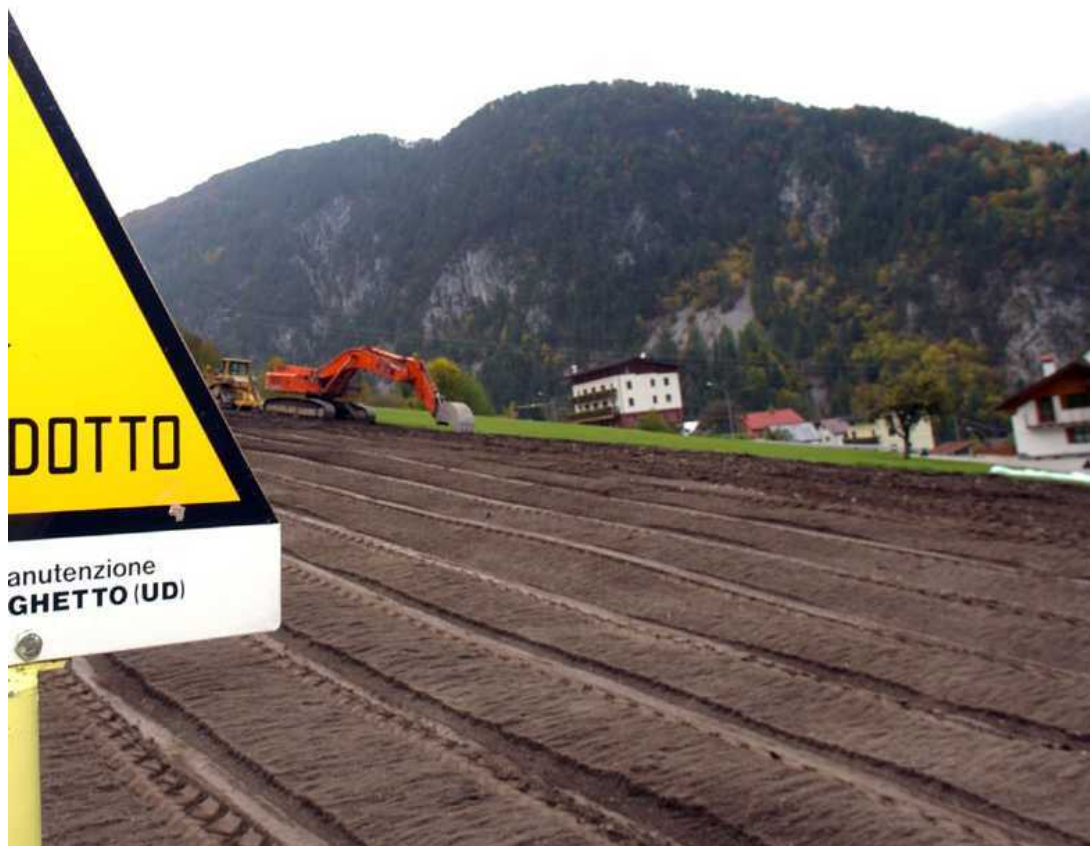
Foto 5.1/H: Ridistribuzione dello strato humico superficiale
