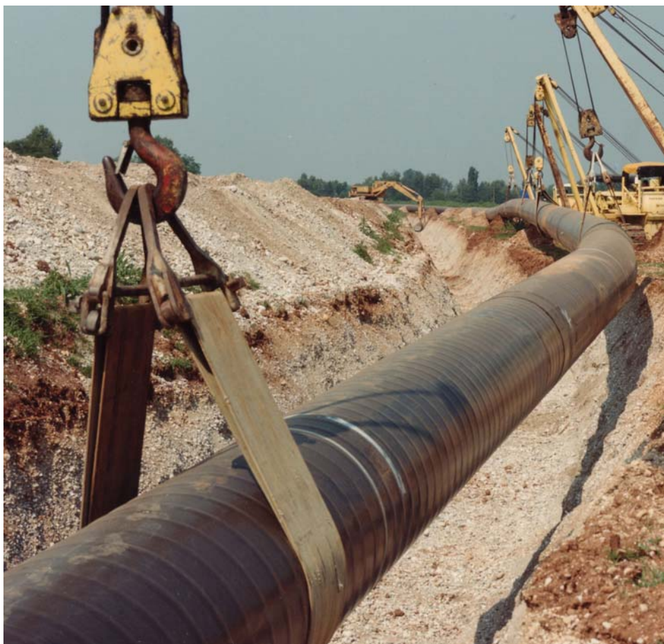
Foto 5.1/E: Posa della condotta
