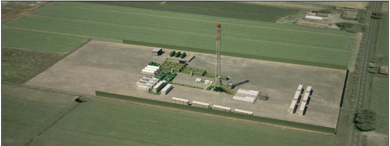
**Fig. 7.4.a - render della fase di cantiere, in evidenza il Rig di perforazione**
