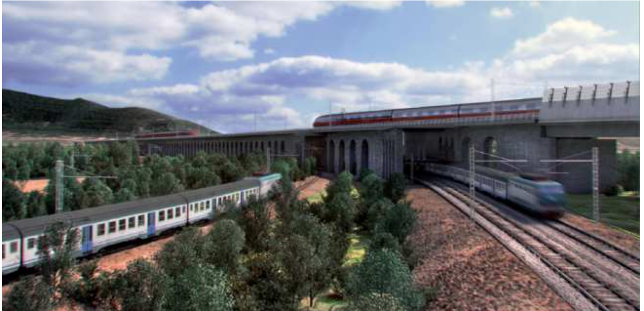
Fig. 8 – VI01 “Struttura ad archi”
