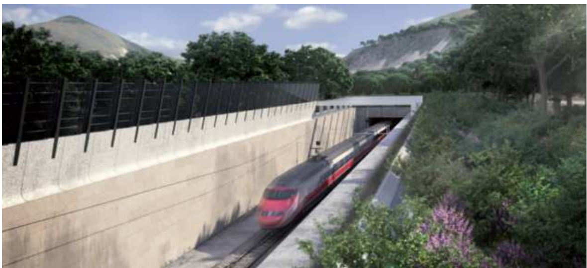
Fig. 1 – Imbocco Sud della Galleria Monte Aglio
