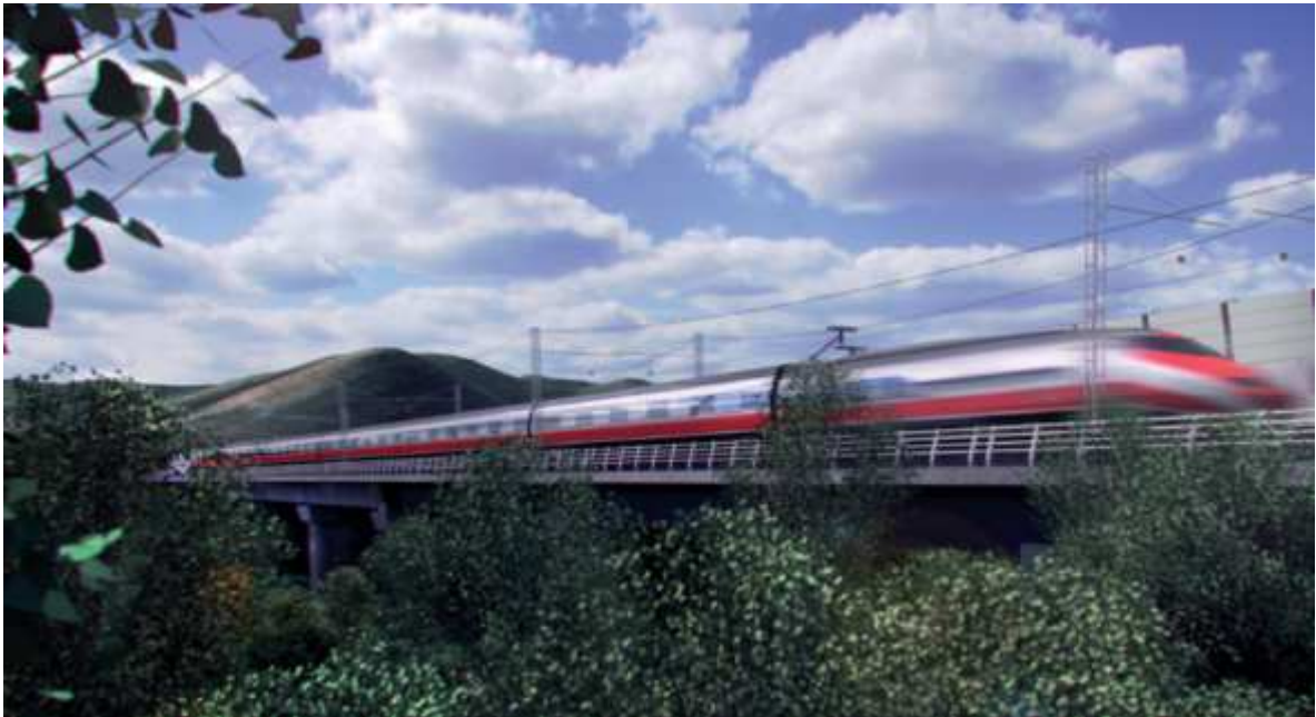
Fig. 4 – VI07 Viadotto Isclero
