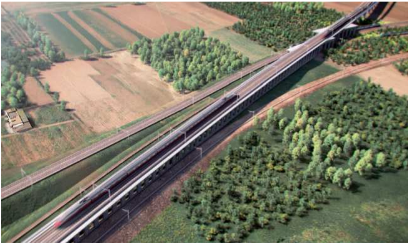
Fig. 7 – Struttura ad Archi – collegamento scalo Marcianise
