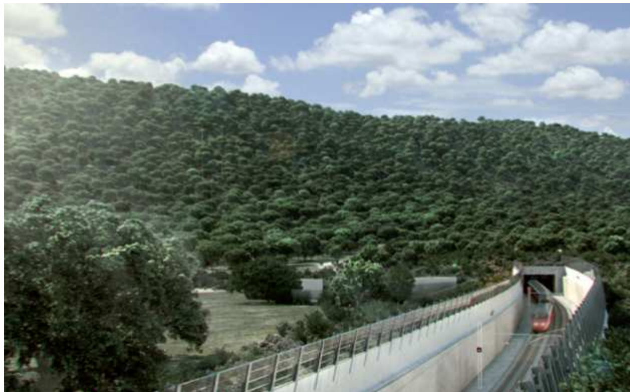
Fig. 2 – Imbocco Nord della Galleria Monte Aglio
